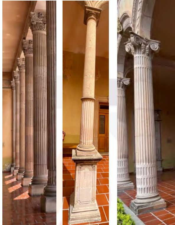
Figura 52. A la izquierda se observa las columnas en el frontón. Al centro las columnas en el primer patio. A la derecha las columnas en el segundo patio. Fuente: Elaboración propia. Fecha: 2022
