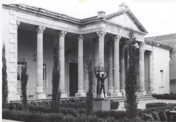
Figura 44. Fachada del Museo Aguascalientes. Fuente Archivo ICA fondo Topete del Valle. Fecha octubre 1975
