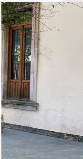
Figura 50. Muro exterior en segundo patio. Fuente: Elaboración propia. Fecha: 2022
