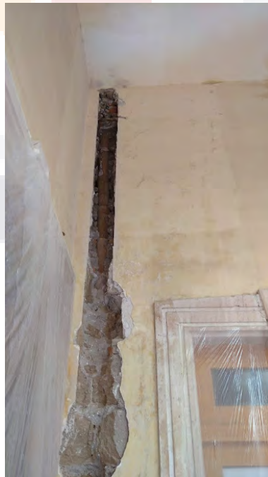
Figura 49. Perforación en muro del primer patio para reemplazo de bajada pluvial. Fuente: Archivo del Instituto Cultura de Aguascalientes. Fecha: 2021
