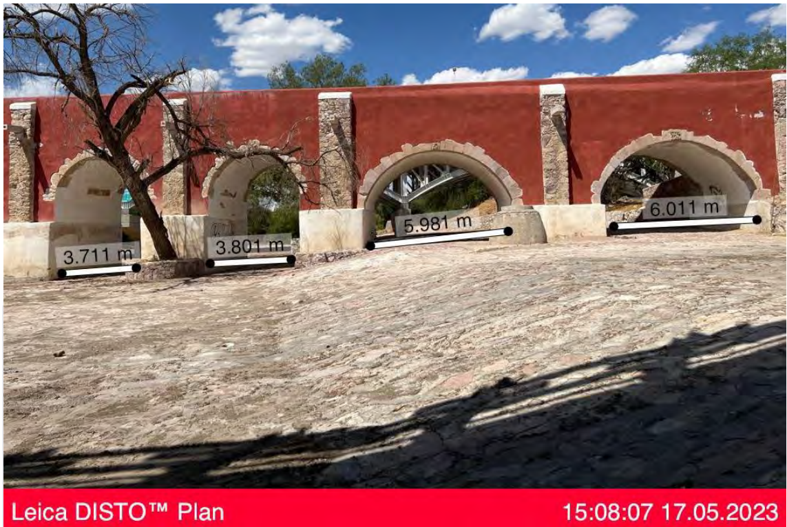
Figura 52. Medición de apertura de los arcos del puente San Ignacio con distanciómetro. Elaboración propia.
