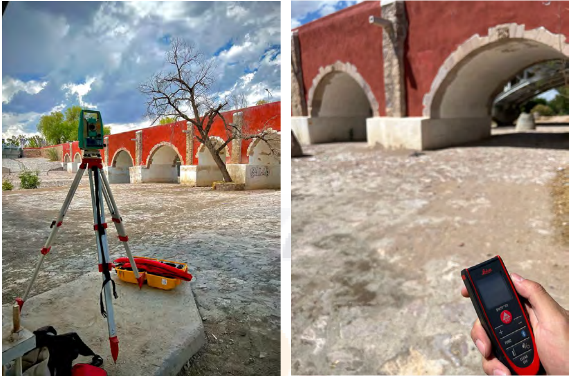
Figura 46. Levantamiento con estación total y distanciómetro. Elaboración propia.
