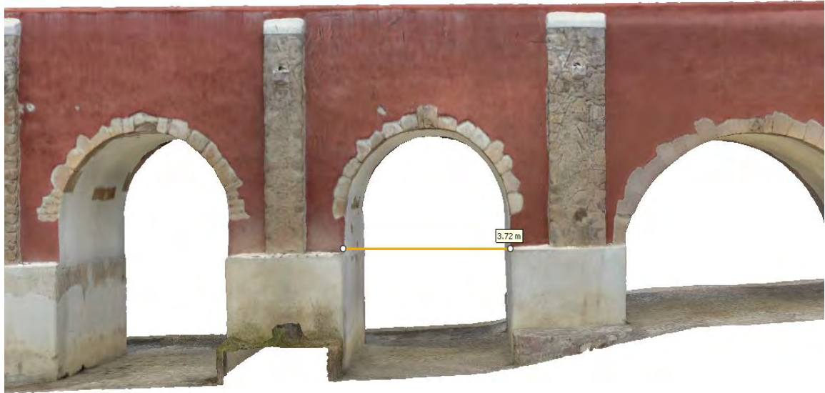
Figura 54. Medición de apertura de los arcos del puente San Ignacio a través del levantamiento fotogramétrico procesado en Agisoft Metashape. Elaboración propia.
