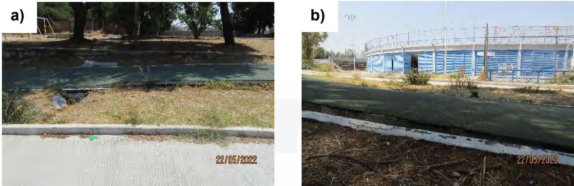
Figura 5.19. a) paso de la falla geológica por trota pista b) Sector del velódromo más cercano a la falla geológica.
