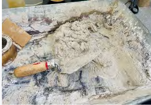
Fig. 22. Elaboración de mezcla de mortero cal-arena 1:2. Fuente: Propia.
