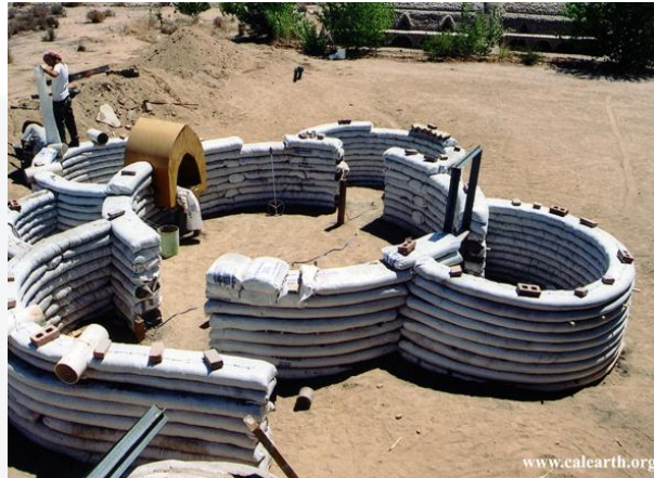
Figura 2.4 Construcción de un ecodomo con superadobe del Cal-Earth Institute
