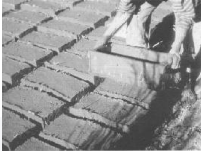
Figura 2.2 Fabricación de una pieza de adobe (Minke,2001)
