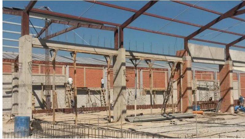
Figura 10. Nave de estructura mixta.
