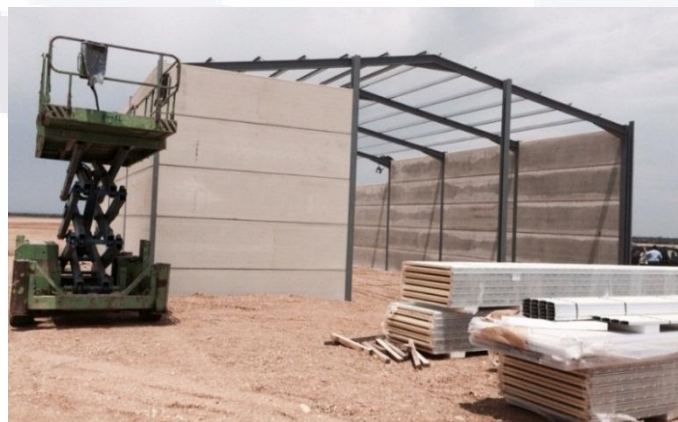
Figura 12. Colocación de fachada sobre nave industrial. (Calavera and Gómez 2001).
