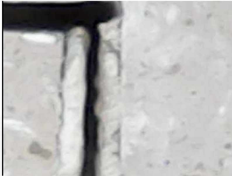
Figura 2.3.5 Junta de adherencia ensayada 43
