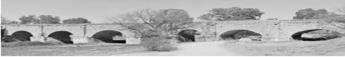
Imagen 3 Puente san Ignacio, propia
