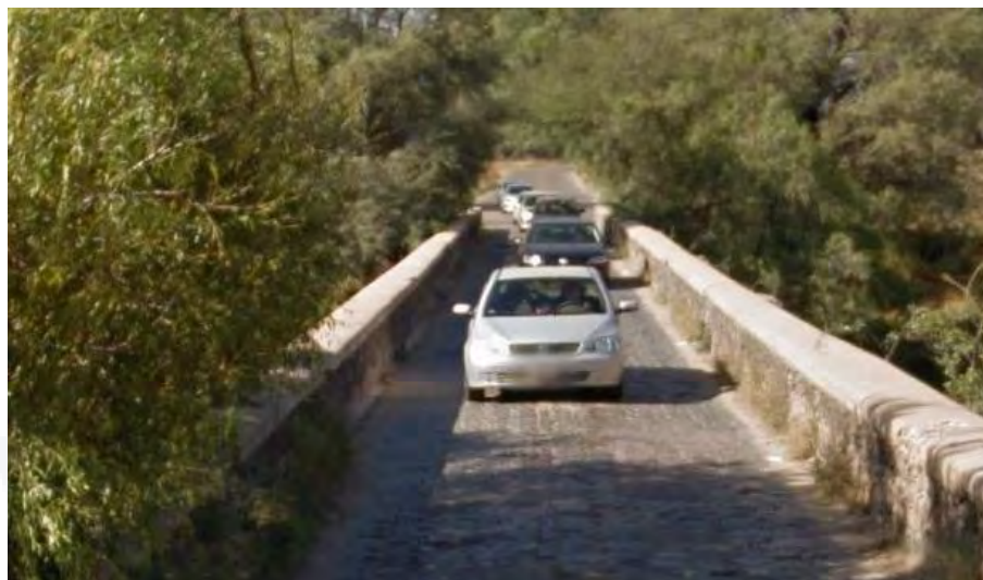
Imagen 7 Vista calzada de puente san Ignacio.
