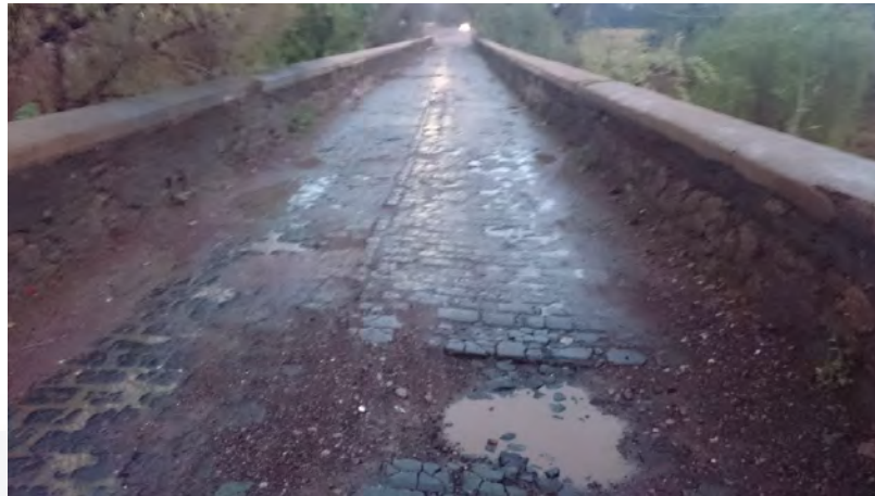
Imagen 32 Vista de vialidad para optimización.
