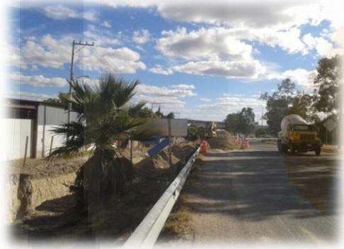
Foto No. 10: Ampliación de carriles en Poblado Peñuelas, año 2014.
