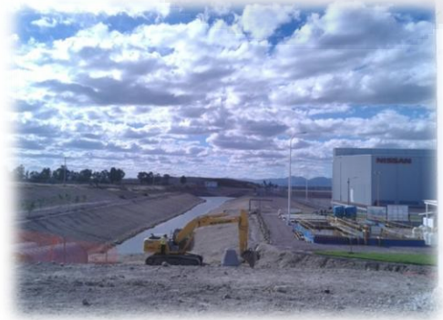
Foto No. 12: Construcción de canal de aguas pluviales, año 2014.
