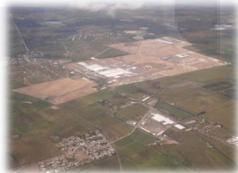
Foto 5: Vista de la NISSAN II Aguascalientes en construcción
