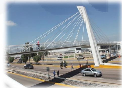
Foto No. 13: Construcción de puente peatonal frente a NISSAN II, año 2014.
