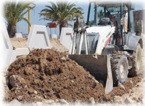
Foto No. 8: Construcción de paso a desnivel Blvd. al Aeropuerto, año 2013.
