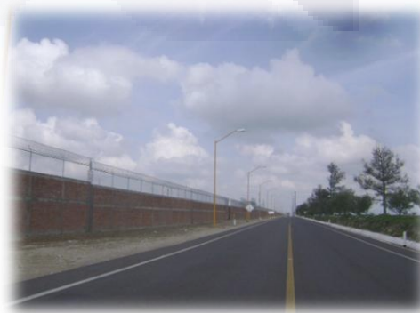
Foto 18: Construcción de nuevas carreteras
