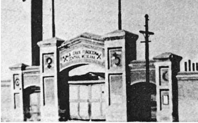
**Imagen no. 4.** Fotografía histórica del acceso a la Fundición. Inicios del siglo XX. A la izquierda se aprecia una fotografía antigua del acceso original del complejo metalúrgico de LGFCM con todos sus elementos, durante sus operaciones en Aguascalientes. Las columnas fueron construidas a base de mampostería; las dos centrales del acceso tenían una altura de unos 10 m aproximadamente; entre ellas se encontraba un enorme arco apuntado en
