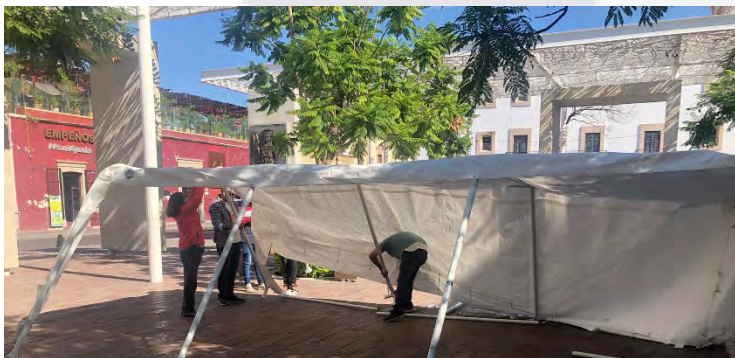
Instalación y acomodo (31)
