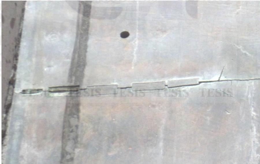
Imagen 23. Cuitláhuac unión con soldadura donde el acabado final se aprecia de mala calidad. (Archivo fotográfico del Centro INAH Aguascalientes).
