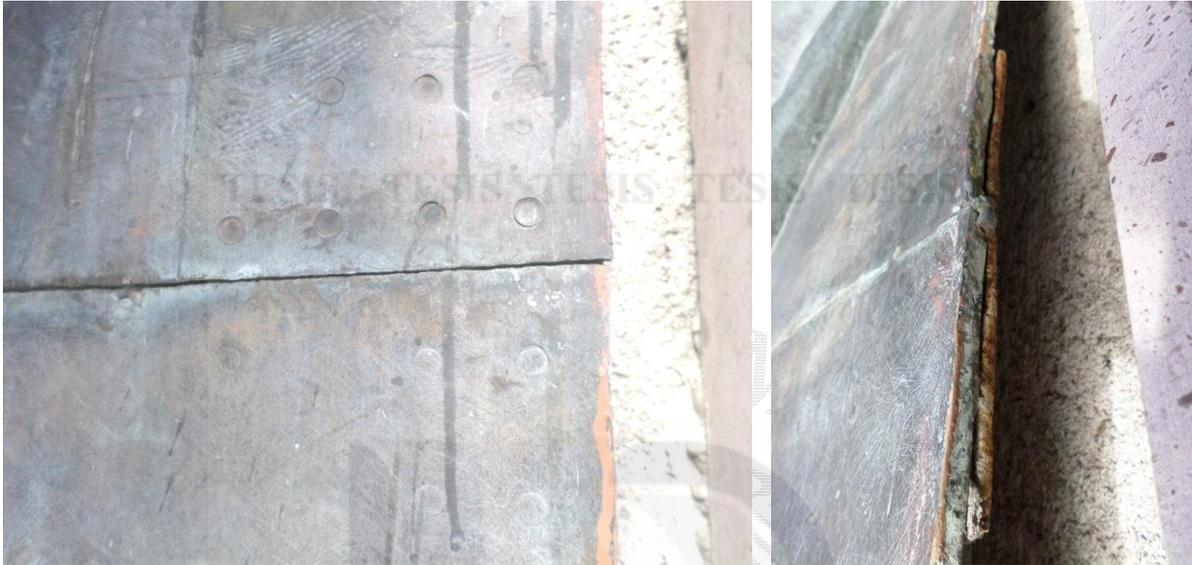
Imagen 24. Cacamatzin unión con placa de metal y remaches de hierro en la parte posterior. (Archivo fotográfico del Centro INAH Aguascalientes).
