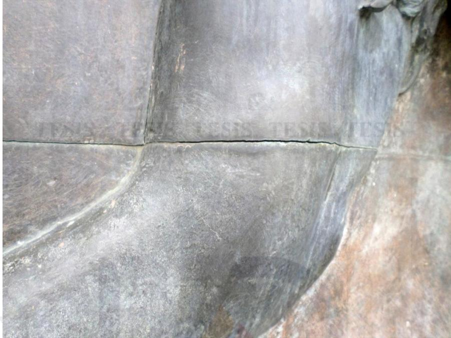
Imagen 22. Cacamatzin unión con soldadura. (Archivo fotográfico del Centro INAH Aguascalientes).
