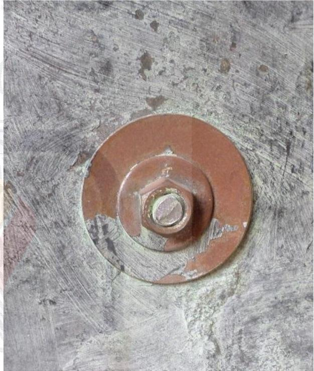
Xochiquetzalli vista de detalle del tornillo colocado en una intervención anterior.
