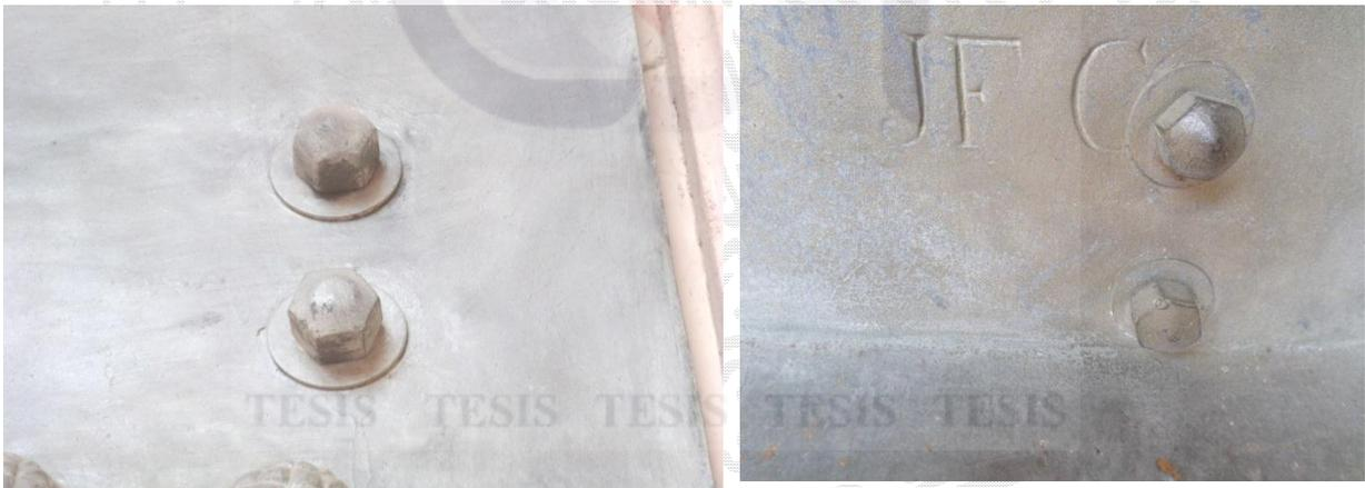
Imagen 12. Escultura de Centéotl tornillos y rondanas originales, obsérvese que de lado derecho este sistema de unión oculta parcialmente la firma del autor. (Archivo fotográfico del Centro INAH Aguascalientes).
