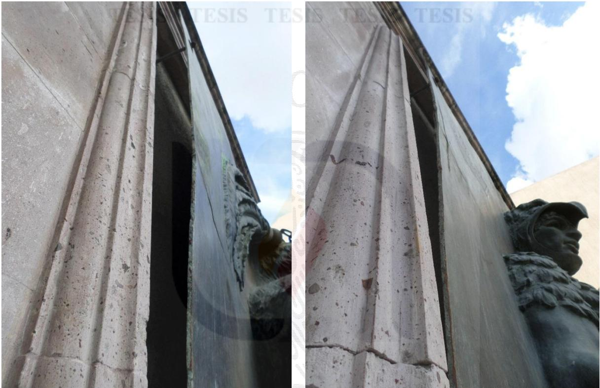
Imagen 14. Deformación por doblez en la parte superior derecha en las obras de Cacamatzin y Cuitláhuac. (Archivo fotográfico del Centro INAH Aguascalientes).
