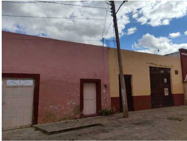
Imagen 37 Fachada 1 (amarilla) Fachada 2 (rosa) a intervenir
