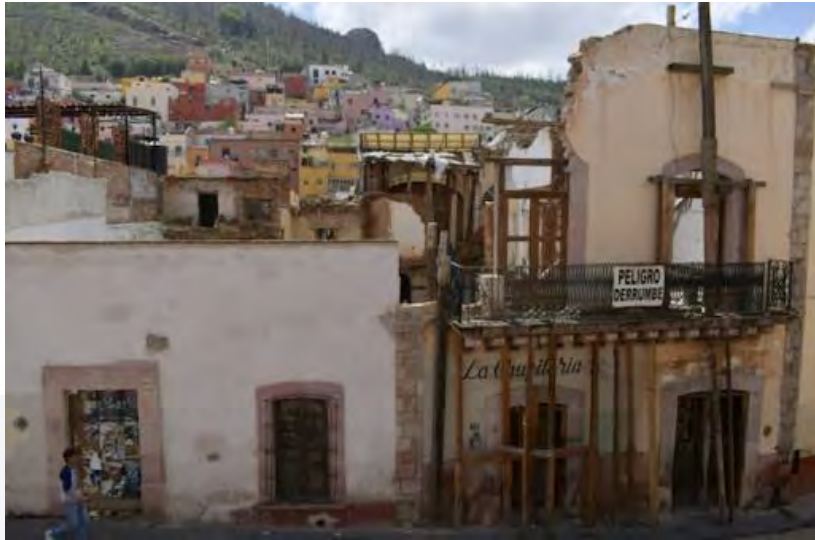
Imagen 3 edificación en mal estado
