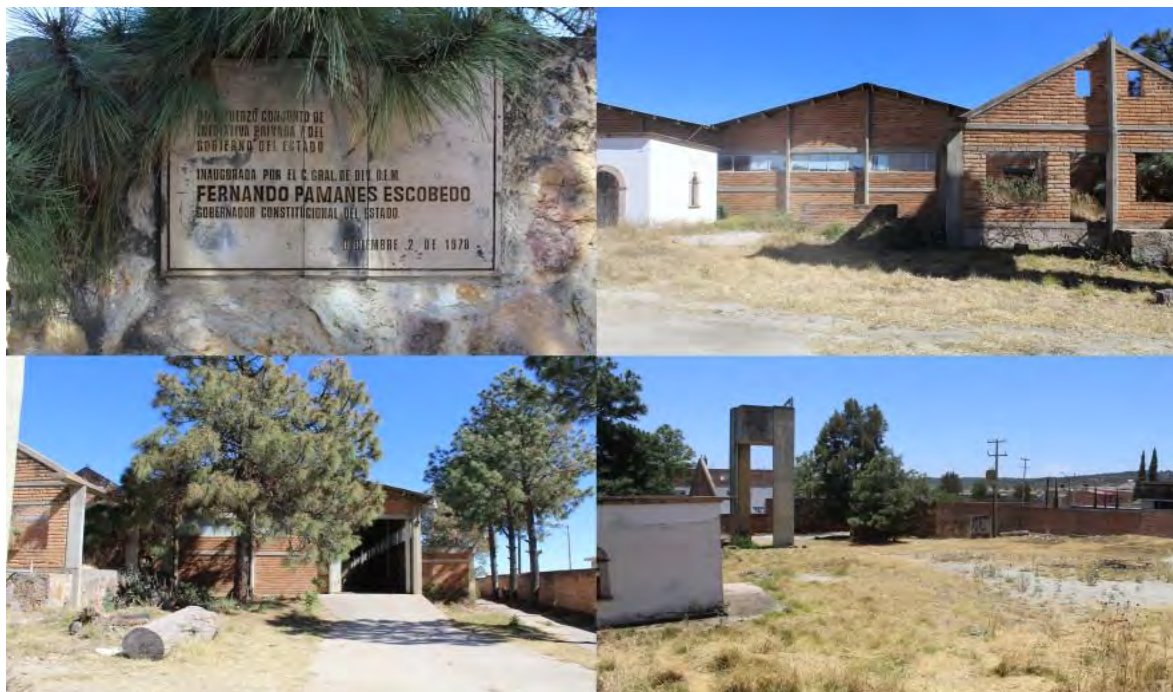
Imagen 24. Elaboración propia. Arriba izq.: Placa conmemorativa de la inauguración. Arriba derecha: Frente de la fábrica, con la capilla e instalaciones incompleta. Abajo izq.: Entrada a la nave principal. Abajo derecha: Patio frontal con tanque de agua potable.
