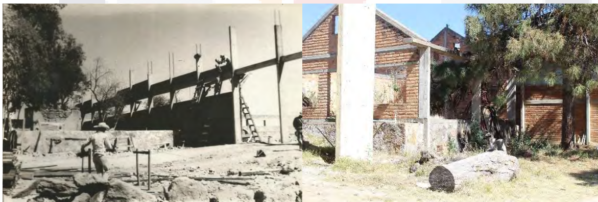
Imagen 30. (Izq.) Cortesía, gerencia de la fábrica de cuadros y marcos, ca. 1978. Imagen de la fachada principal durante la construcción de la nave principal de la fábrica. (Der) Elaboración propia. 2020. Imagen de la fachada de la fábrica en la actualidad.
