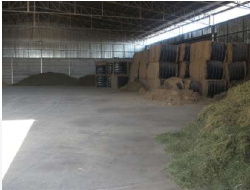
Figura No. 4 Almacén de alimentos
