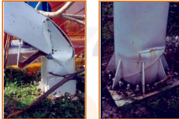
Imagen 10 y 11, fallas en el pedestal. Fuente Artículo de Divulgación Baeza J. et. al. / Ingeniería 8-3 (2004)
