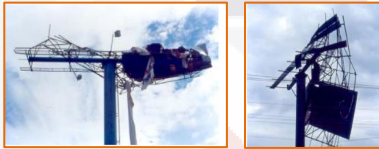
Imagen 7 y 8, fallas en paneles. Fuente Artículo de Divulgación Baeza J. et. al. / Ingeniería 8-3 (2004)
