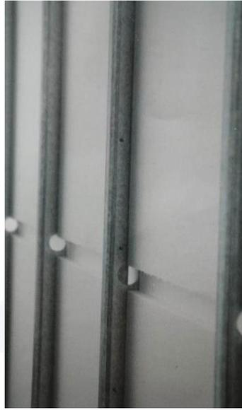
**Figura 8: Ajuste del poste con el poliestireno (GBS, 2011).**
