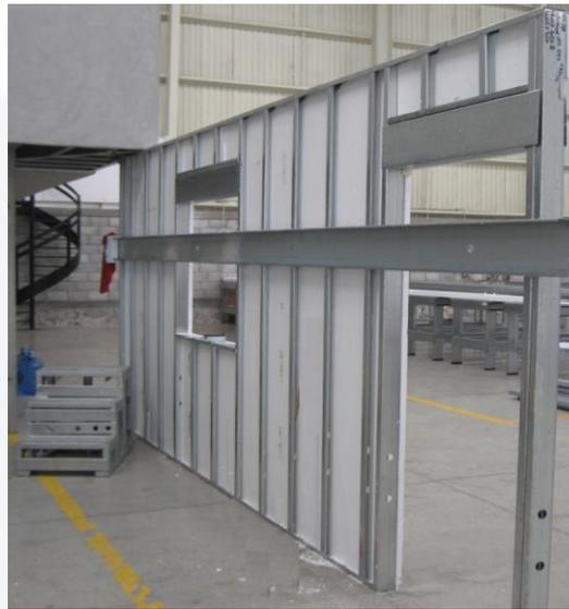
**Figura 5: Sistema constructivo LGSF.**
