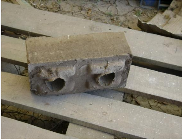
Figura 15. Vista del bloque de tierra compactada con aristas despostilladas.
