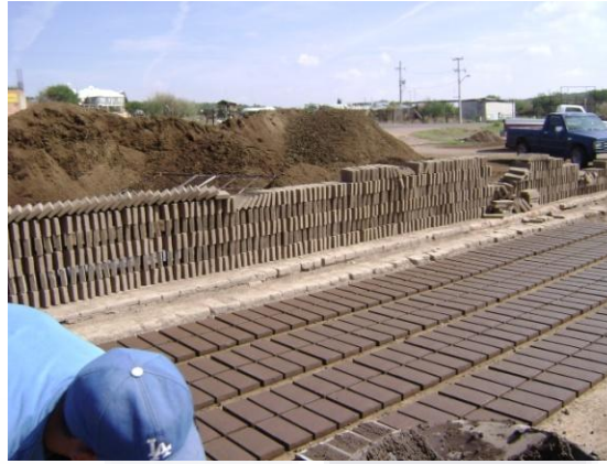
Figura 39. Vista general de los tabiques moldeados.
