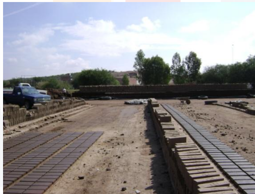
Figura 40. Vista general de tabiques en proceso de secado.
