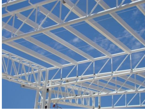
Ilustración 16 Gimnasio de Box Línea Verde, Aguascalientes
