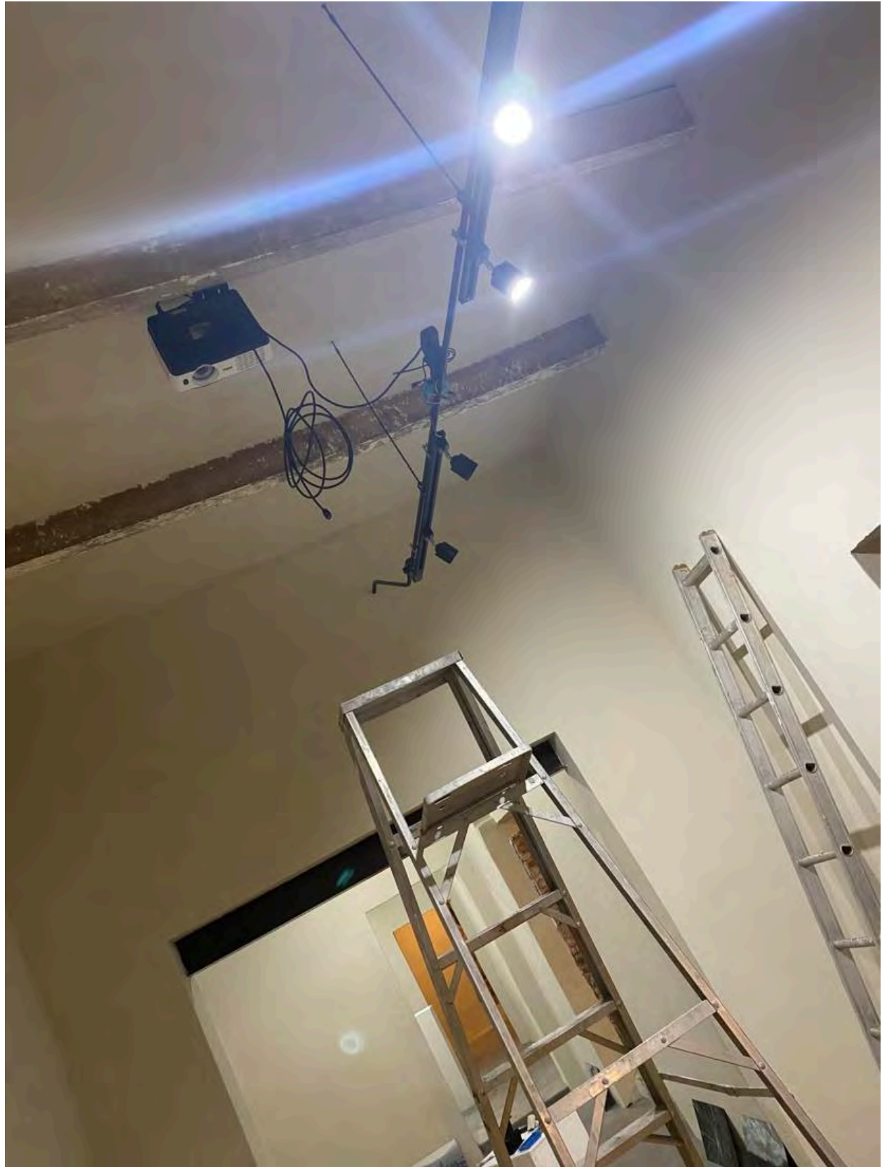
Imagen 10. Cambio de activación de obra mecánica a obra visual: instalación de proyector.
