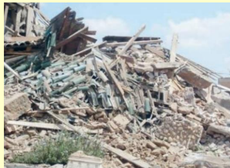
Fotografía 2. Demolición de la casa de Salomón Rivera en julio de 2012 (Espino, 2012)
