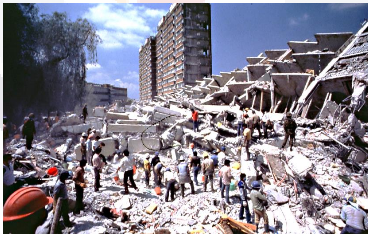
Figura 3.1.1f. Edificio C-4 de multifamiliar Juarez, colapsado debido al sismo de 1985. (imagen de https://www.viajabonitomx.com/2013/09/10-datos-sorprendentes-del-terremoto-de.html )
