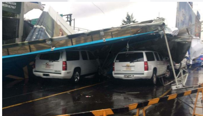
Fig. 3.2.1c. Anuncio espectacular colapsado debido a fuertes rachas de viento y lluvia (Cd. Mx., Mexico 2017)
