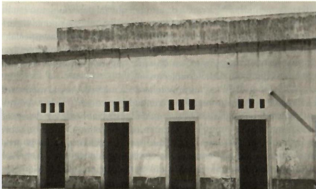
Ilustración 4. Fachada externa del Departamento para Dementes
