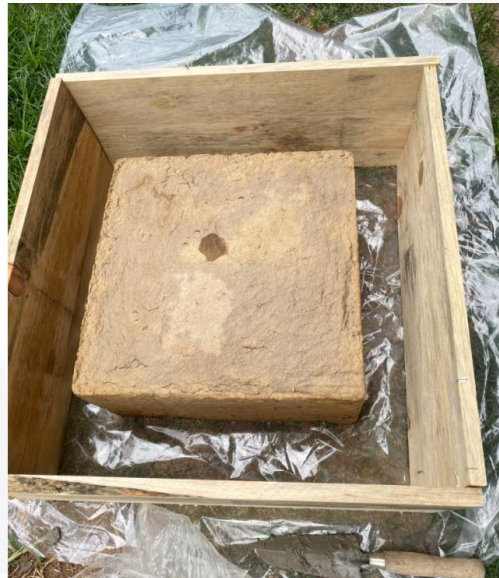
Imagen No. 21 Casetón y cimbra utilizadas
