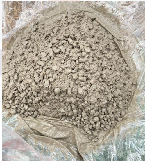
Imagen No. 23 Mezcla de concreto f'c=200\text{kg/cm}^2
