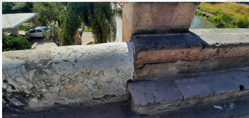
**Figura 122:** Pérdida de Sección, Desplomes, Ausencia de Juntas y Manchas Humedad en los Parapetos del Puente Lagos de Moreno (Imagen del Autor).
