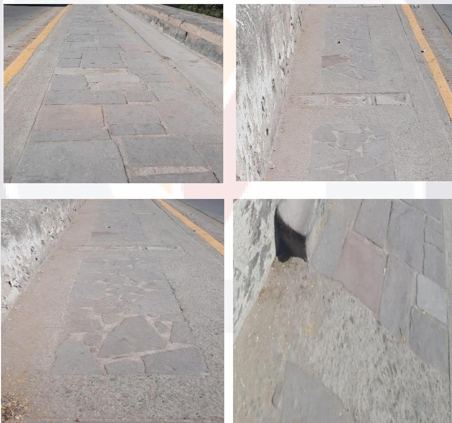
**Figura 124:** Pérdidas de Juntas, Discontinuidades y Desniveles en la banqueta del Puente de Lagos de Moreno (Imagen del Autor).
