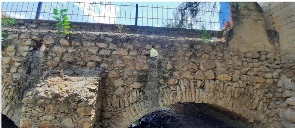
**Figura 102:** Pérdida de Juntas en Bóvedas y Muros de Enjuta (Imagen del Autor).
