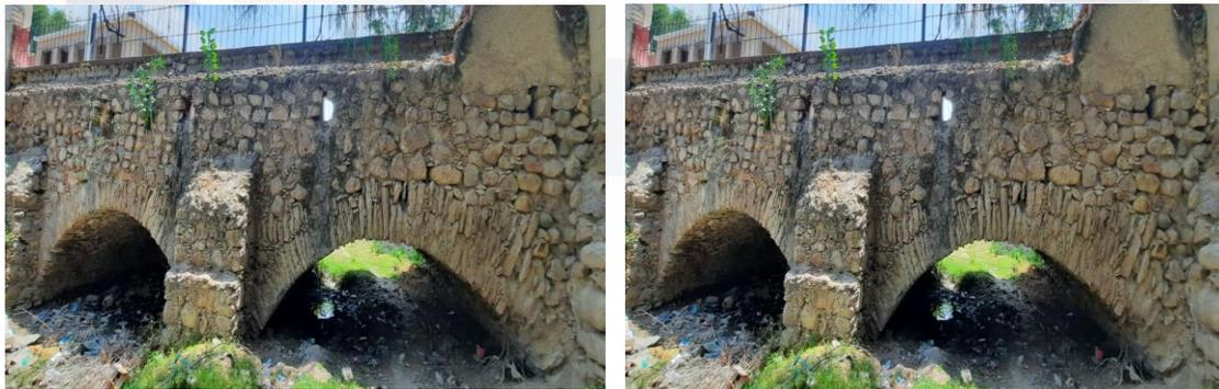
**Figura 101:** Presencia de Vegetación y Manchas de Humedad en los Tímpanos, las Pilas y los Arcos del Puente de Guadalupe (Imagen del Autor).
