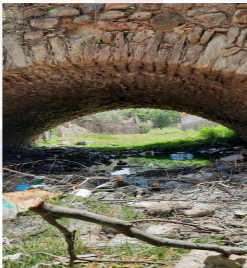
**Figura 103:** Acumulación excesiva de escombros y suciedad debajo del Puente de Guadalupe (Imagen del Autor).
