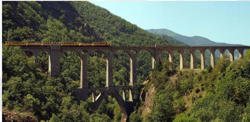
**Figura 31:** Viaducto de Fontpedrouse, Francia, ubicado sobre el río Tet, con arcos de 17 m de luz y un arco ojival de 30 m (Héctor Aldo Bardales Salazar, 2012).
