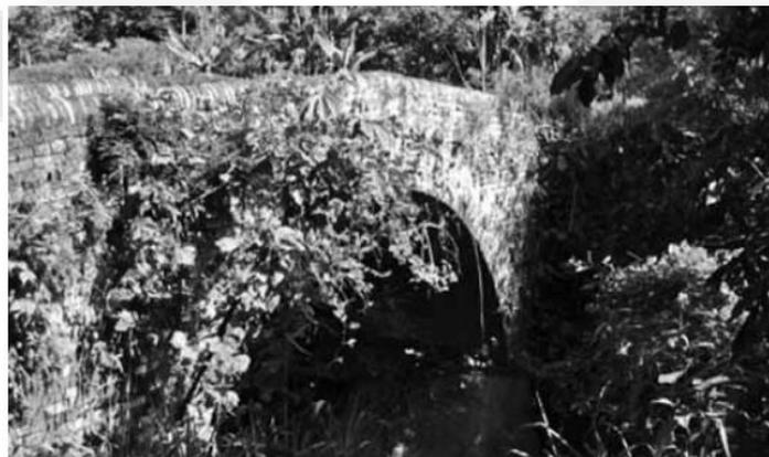
**Figura 59:** Presencia de vegetación sobre el puente Quilcacé en la zona de Alta Cauca, Colombia (Galindo Díaz & Paredes López, 2011).
