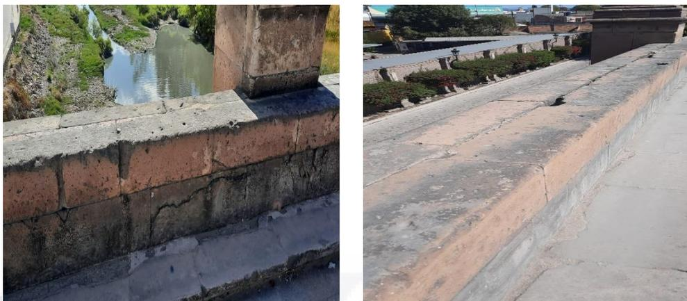
**Figura 123:** Agrietamientos en los Parapetos del Puente de Lagos de Moreno.
