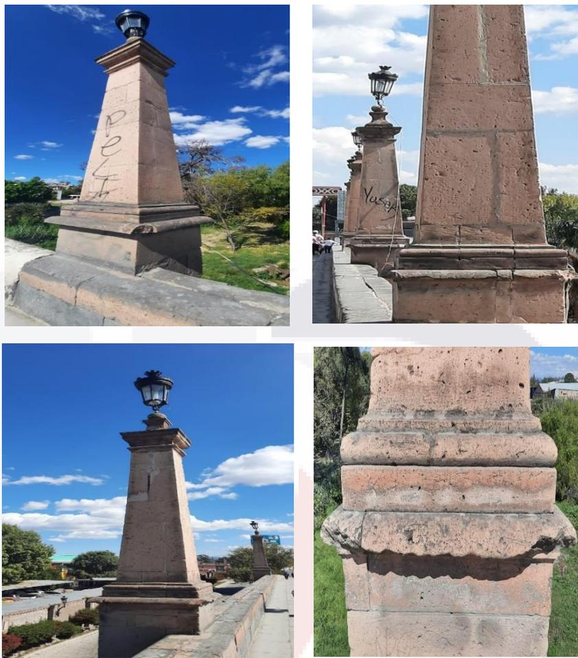
**Figura 119:** Deterioros más significativos en el sistema de iluminación del Puente de Lagos de Moreno (Manchas de Humedad, Desconchado, Instalaciones Expuestas y Pérdida de Juntas) (Imagen del Autor).
