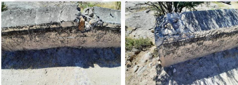
**Figura 92:** Agrietamientos, Pérdida de Sección, Desconchados y Manchas de Humedad observadas en los parapetos de Puente Blanco (Imagen del Autor).
