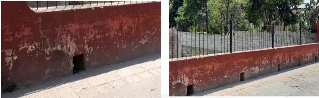
**Figura 107:** Eflorescencia, Pérdida del Recubrimiento y Manchas de Humedad en los Parapetos del Puente de Guadalupe (Imagen del Autor).
