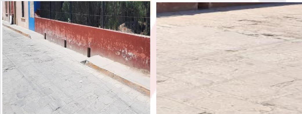
**Figura 104:** Pérdida de juntas, hundimientos y desniveles en el Puente de Guadalupe (Imagen del Autor).
