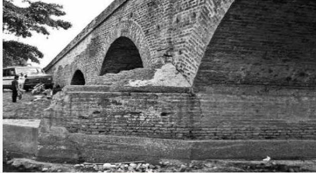
**Figura 60:** Fisuras en la base de las pilas del puente sobre el río Güengüé, en la vía entre Miranda y Corinto (Cauca, Colombia) (Galindo Díaz & Paredes López, 2011).
