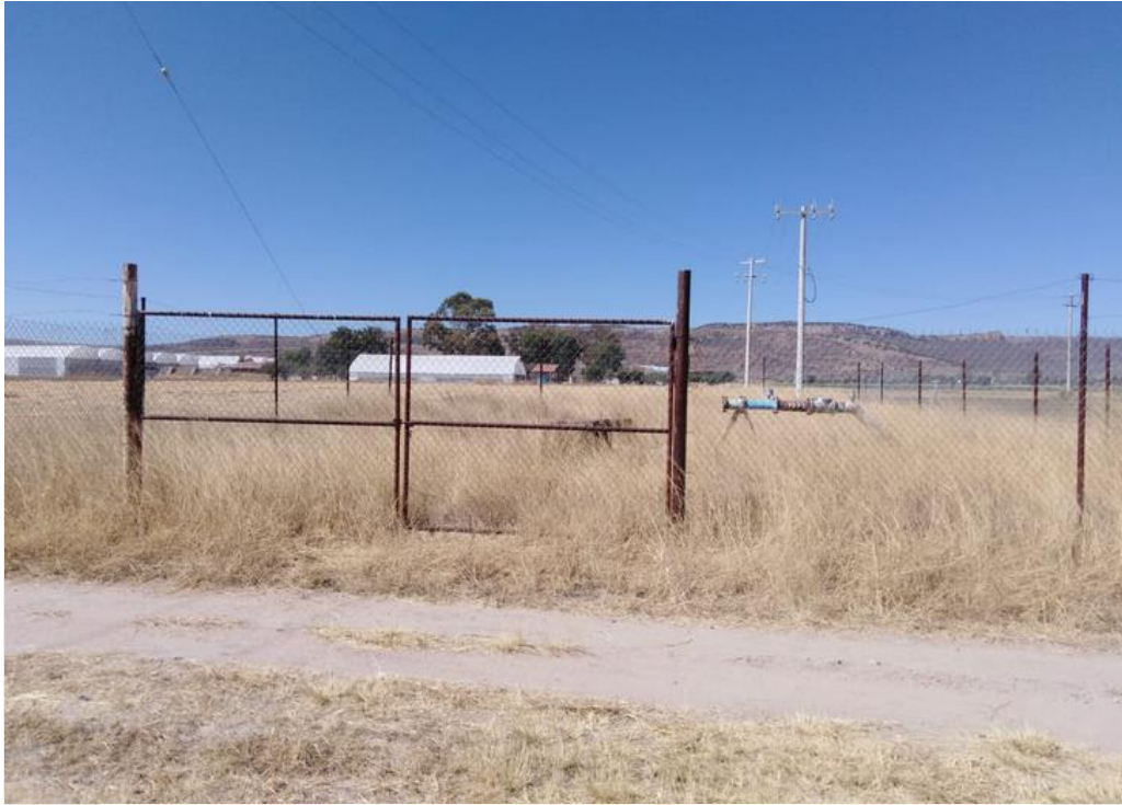
Ilustración 6. Vista frontal de la ubicación del pozo inactivo.
