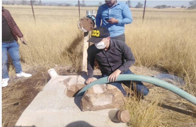
Ilustración 14. Vaciado de agua potable dentro del pozo.
