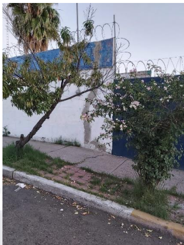
Figura 8, 9. Fractura en muro de mampostería en calle paris
