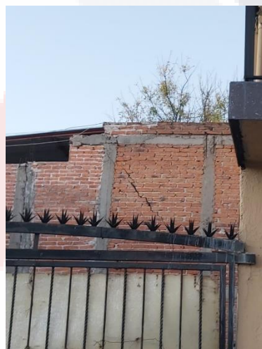
Figura 10, 11. Falla por tensión diagonal calle paris
