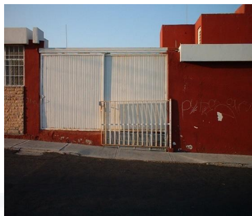
Figura 14, 15. Asentamiento diferencial calle Navarete
