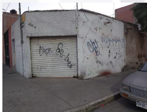
Figura 12, 13. Asentamiento diferencial calle Navarete
