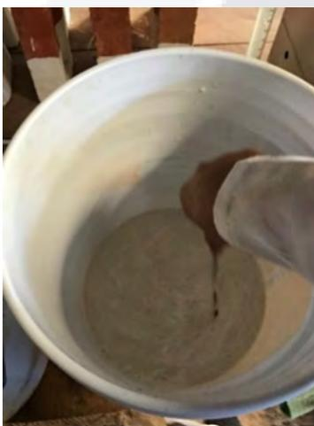
Fig. 39. Mezclado de materiales para impermeabilizante. Escurrecimiento de agua y mucílago de nopal. (Elaboración propia)
