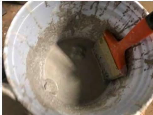
Fig. 49. Brocha para aplicación de segunda mano de impermeabilizante.
