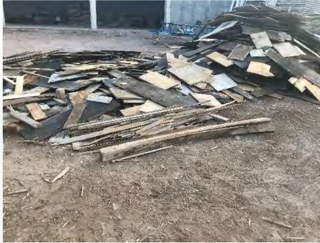
*Fig. 5. Pila de madera de cimbra en desuso, con espesor de 1-2". (Elaboración propia)*
