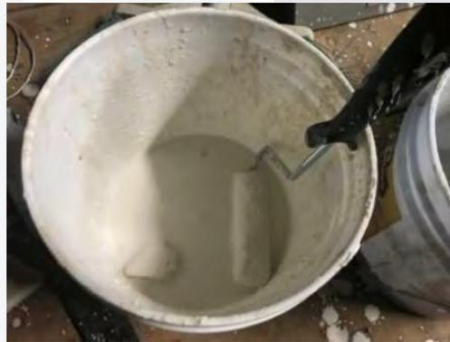
Fig. 48. Aplicación con rodillo de primer mano. Ecurrimiento de agua y mucílago de nopal. (Elaboración propia)
