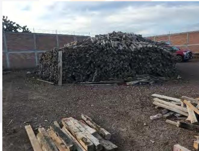
*Fig. 6. Pila de madera de cimbra en desuso, polines de 4x4". (Elaboración propia)*
