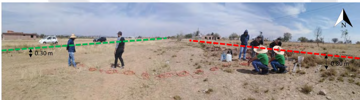
Figura 4. Imagen del sitio. La línea roja corresponde a una falla normal y la línea verde a una grieta.
