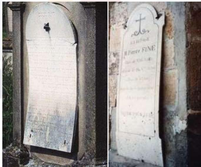
Ilustración 14 De lado derecho se observa una deformación cóncava y del lado izquierdo una deformación convexa. Francia. Obtenido de (ICOMOS, 2011)
