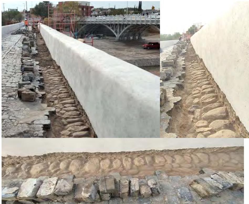
*FIGURA 17 Retiro de la primera capa de bloques de fundición a los costados de la calzada. (Villanueva Clavel, 2020)*
