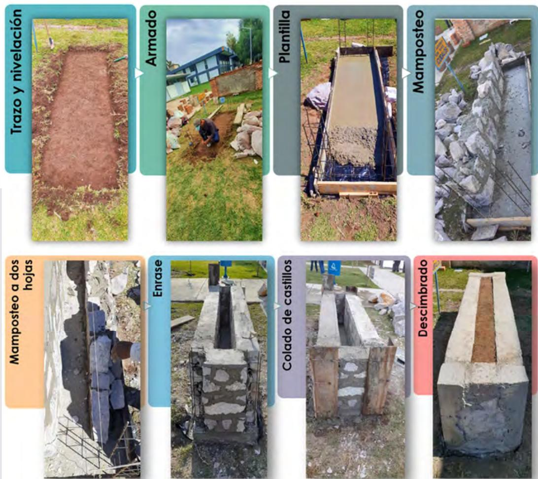
FIGURA 31 Proceso constructivo del modelo experimental. Elaboración Propia
