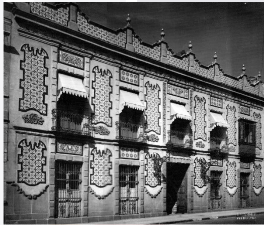
Imagen 49 Fachada en 1933. Fuente Colección personal de la empresa
