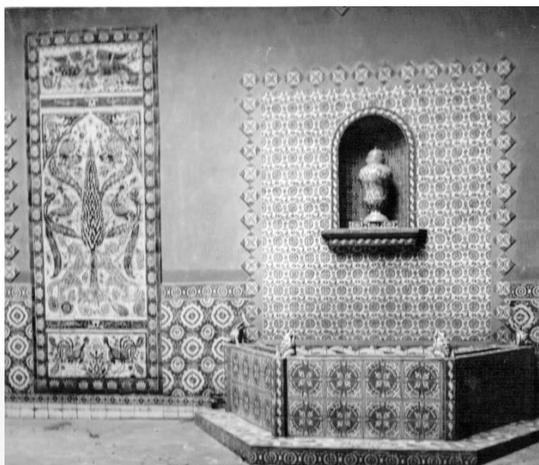
Imagen 54 Fuente del primer patio 1930 Fuente Colección particular de la empresa
