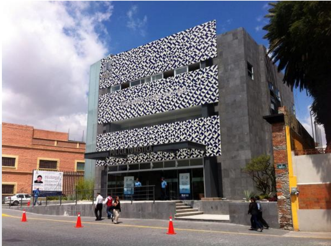
Imagen 34 Edificio de policía turística, fachada recubierta de talavera. Fuente https://mobile.twitter.com/contextopue
