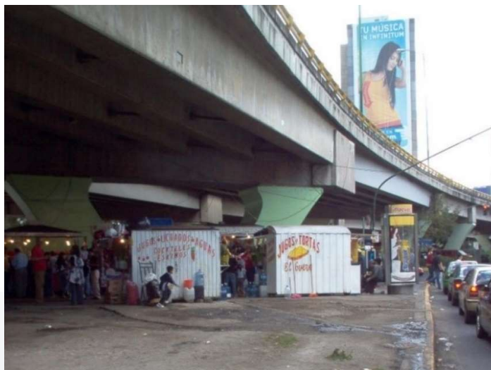
Figura 07 – Ejemplo de subproducto urbano localizado en Ciudad de México.
