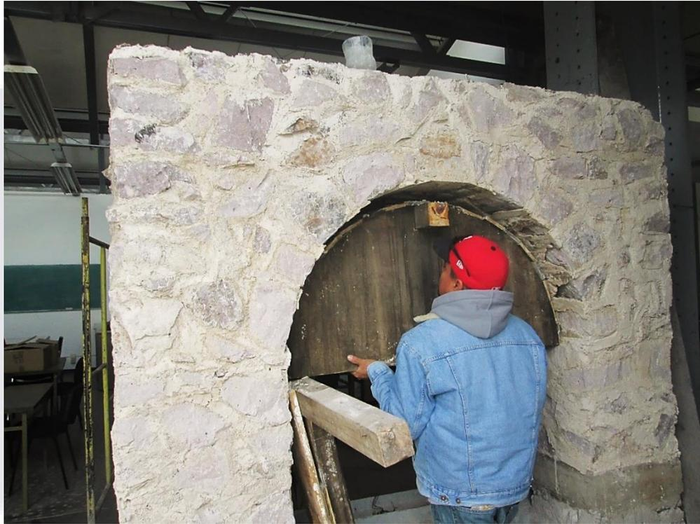
Figura 58 Descimbrado de modelo a escala. Elaboración propia.
