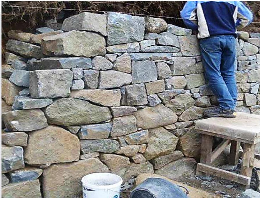
Figura 13 Colocación de mampostería seca. ("Bruc Yardi").
