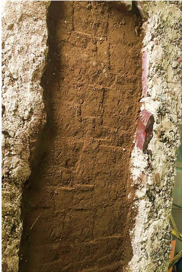
Figura 55 Relleno compactado. Elaboración propia.
