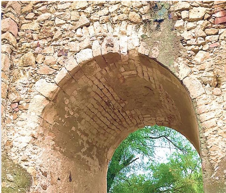
Figura 6 Bóveda de piedra con desprendimiento de juntas. Imagen propia.
