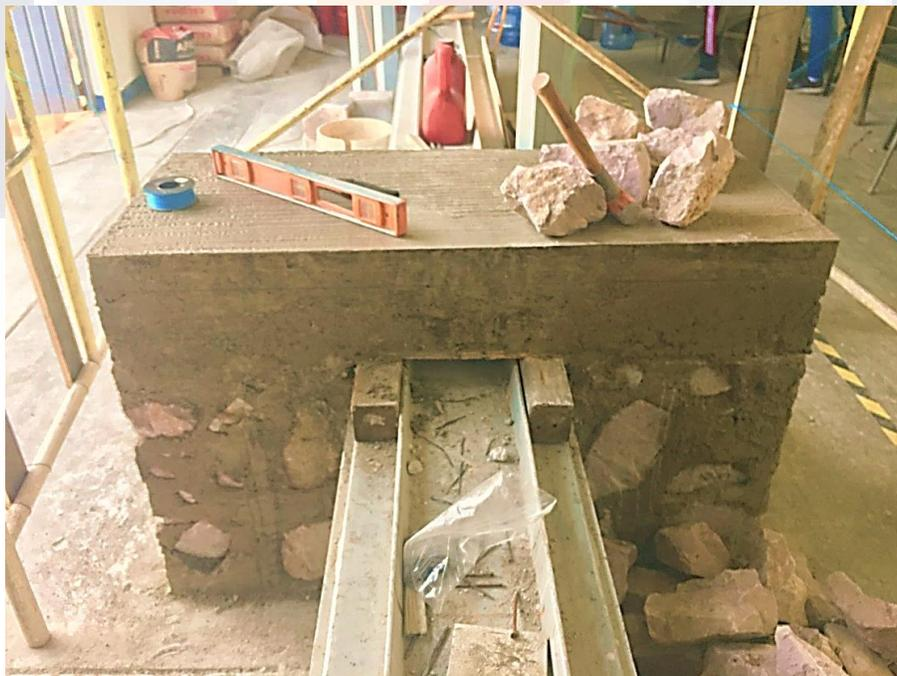
Figura 48 Placa de transición entre pilas secundarias y pilas primarias. Elaboración propia.
