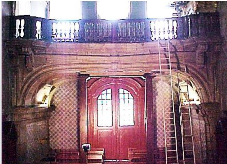
Figura 2 arco del coro alto con desplazamiento vertical. (Costa et al., 2014).
