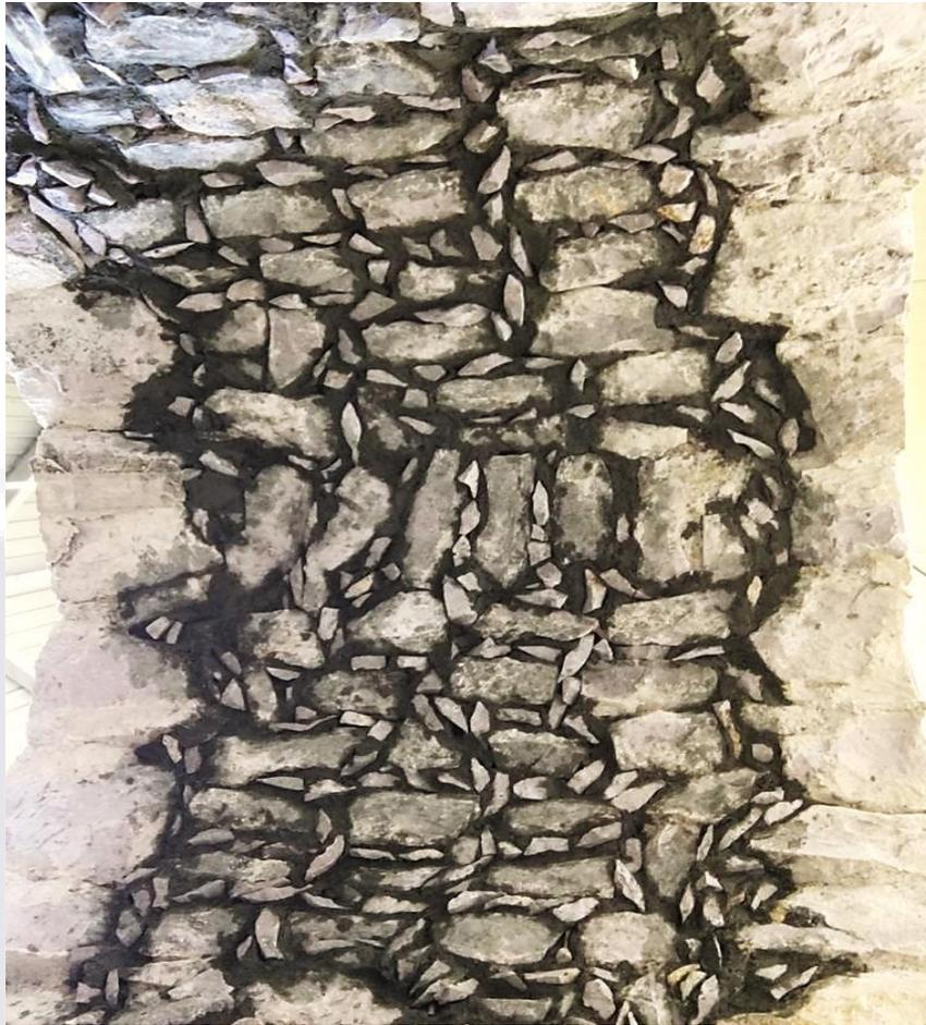
Figura 44 Intradós del modelo a escala, con el método del "rajuado" aplicado. Elaboración propia.
