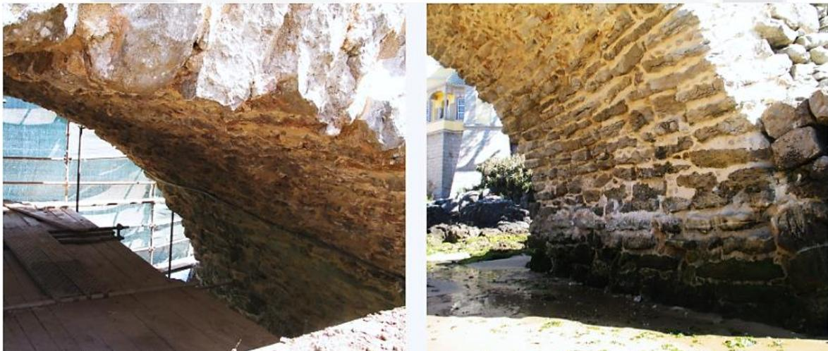
Figura 5 Puente "Santa Marta" con las juntas restituidas, (João *et al.*, 2014).
