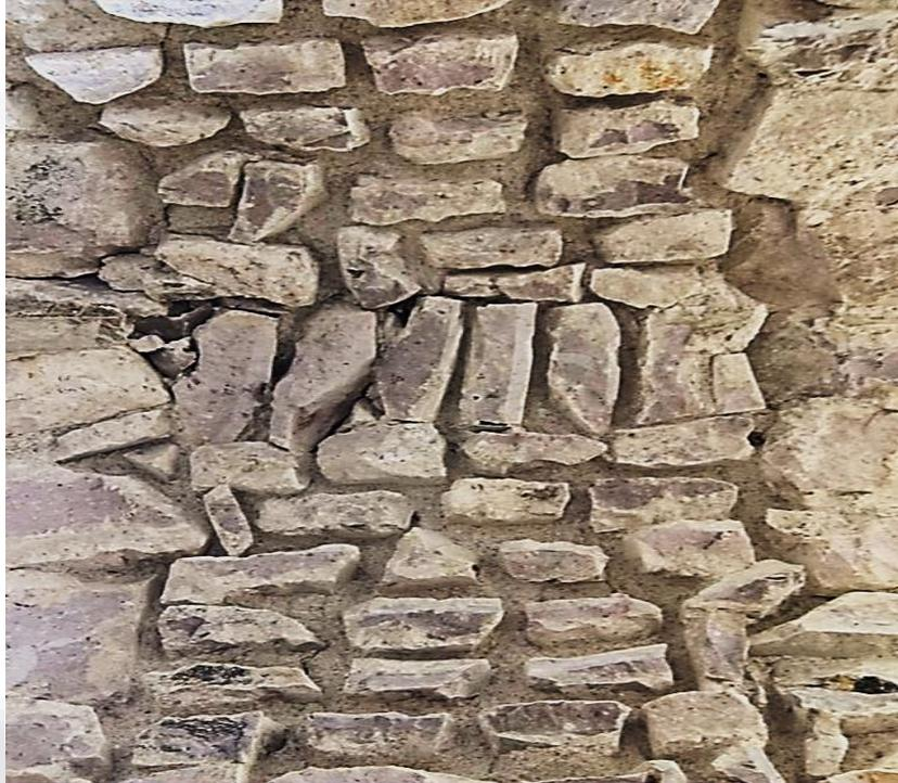
Figura 43 Intradós del modelo a escala, con la junta desgastada. Elaboración propia.
