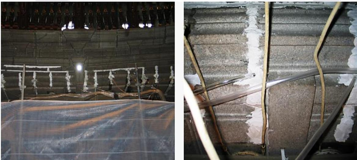
Figura 3 Vista inferior del arco con las juntas selladas. (Costa et al., 2014).
