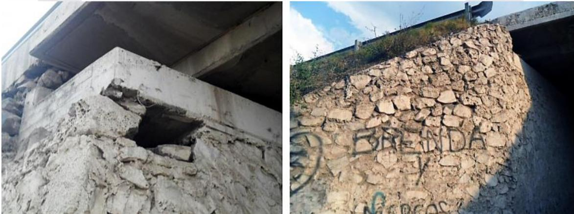
Figura 9 puentes con desprendimiento de juntas y huecos en sus paredes. (SCT, 2018)
