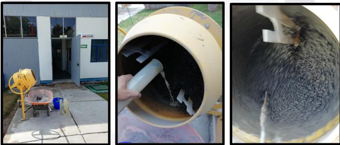
Figura 30. Procedimiento de mezclado del concreto permeable. Fuente: autoría propia.
