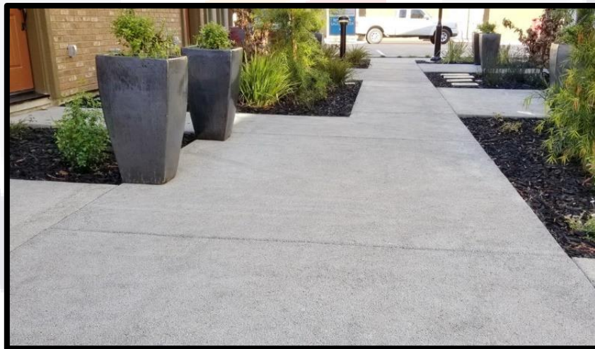
Figura 14. Concreto permeable de grano fino pulido colocado en una acera en Sunnyvale California. Obtenido de Bay Area (2019).
