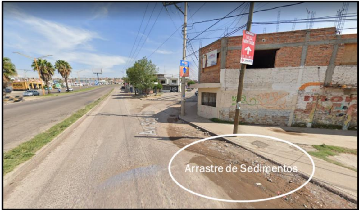
Figura 2. Zona de inundación en el cruce ubicado entre la Av. Siglo XXI y la calle Sierra Tepehuanes. Existe evidencia del arrastre de sedimentos generado durante los eventos de precipitación. Fuente: Google Maps (2019).
