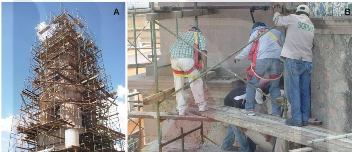
Figura 7. Trabajos de restauración en la torre norte de la catedral. A) Estructura de andamios colocados para la ejecución de los trabajos. B) Colocación de pieza nueva de cantera sobre moldura.
