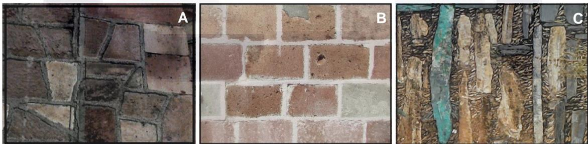
Figura 29. Muros con mejor ICM. A) Muro “a” de la catedral de Aguascalientes con valor de 5.04. B) Muro “c” de la catedral de Aguascalientes con valor de 5.6. C) Muro “h” de la presa de Tepezalá con valor de 5.04.
