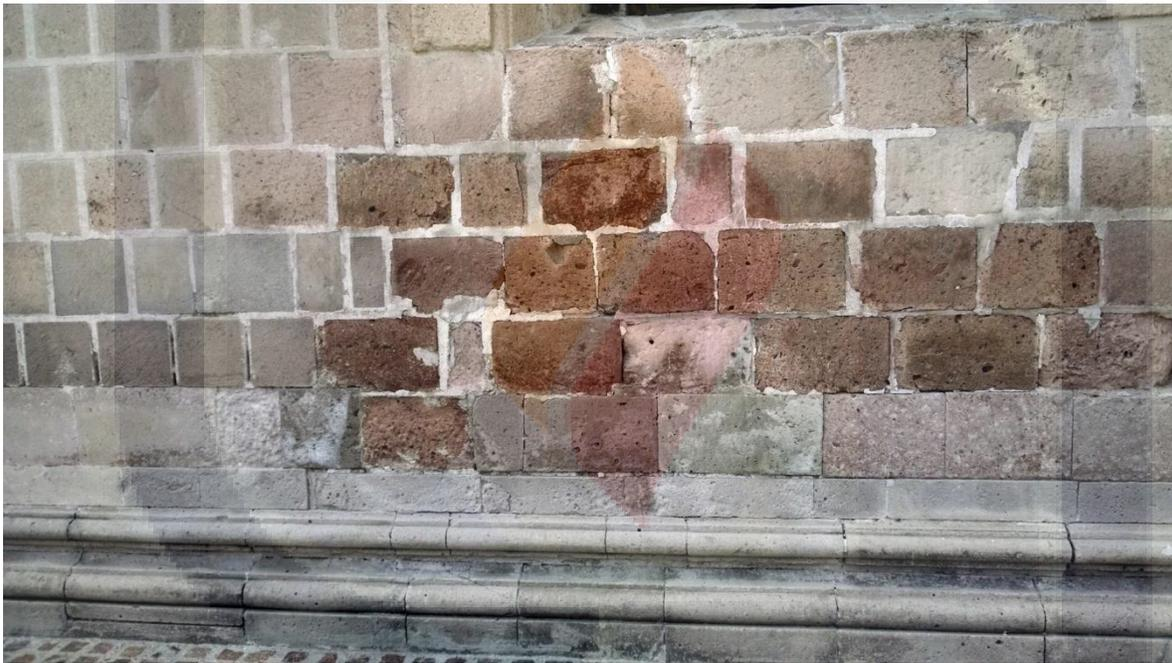
Figura 9. Zona deteriorada sobre la fachada frontal de la catedral
