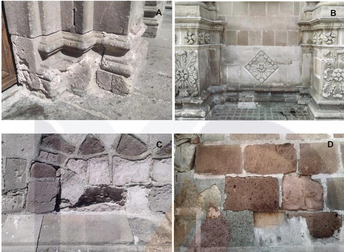
Figura 30. Deterioro de la Catedral de la Ciudad de Aguascalientes debido a la intemperización y a la humedad. A) *Black crusts*, *soiling*, *scratch*, áreas húmedas y humedad ascendente en la pared al lado derecho del acceso principal al templo. B) *Black crusts* y contaminación por residuos humanos, suciedad y humedad ascendente en el fondo de la pared en el lado derecho de la puerta de acceso. C) y D) Humedad ascendente y flaking en rocas de la pared norte.
