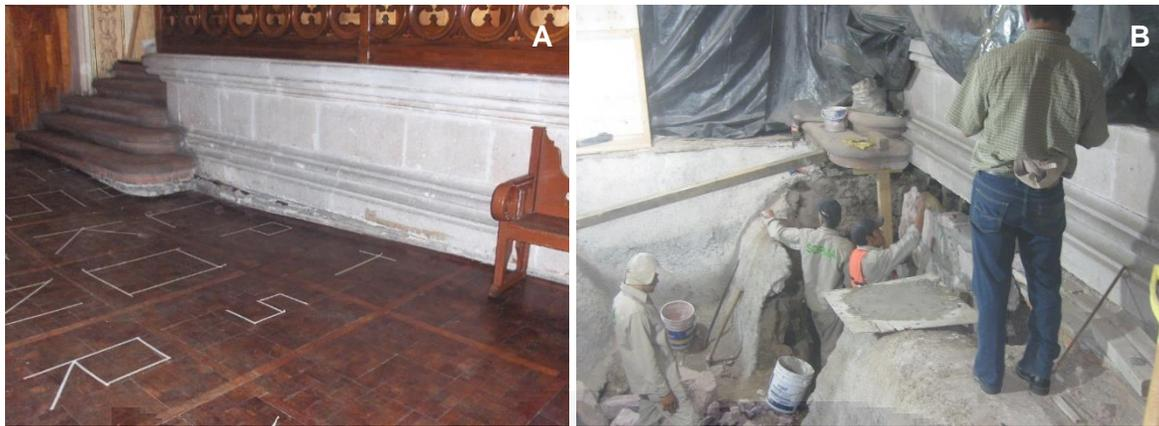
Figura 5. Problemas de asentamiento en el piso de catedral a un costado del presbitero. A) Diferencias de nivel de piso antes de los trabajos de excavación. B) Trabajos de contención y estabilización de suelo durante excavación de zona con mayores asentamientos.
