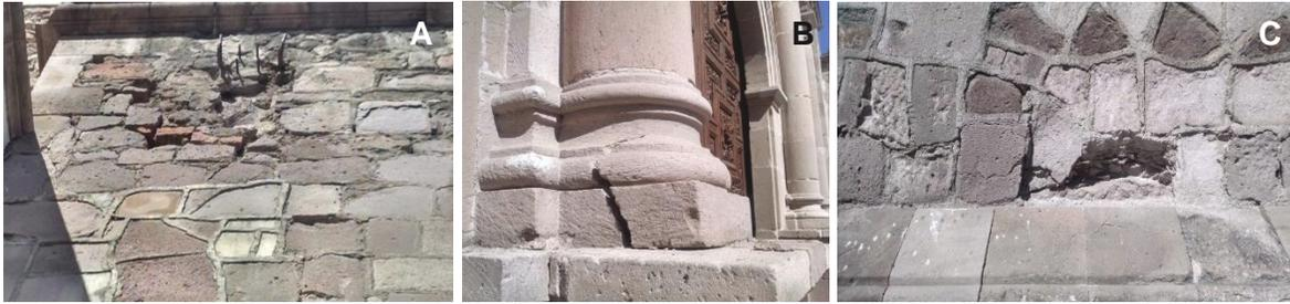
Figura 11. Zonas de mayor degradación en el lado sur de la catedral. A) Zona deteriorada en la parte superior del muro generada por el deficiente sistema de drenaje en la azotea de la nave lateral. B) Fractura de la columna circular ubicada a un costado del acceso al interior del templo. C) Daños por *flaking* y *scaling* en la parte inferior de los muros debido al efecto de la humedad por capilaridad.
