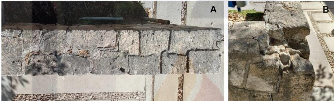
Figura 45. Sección del muro 1. (A) Imagen de planta, (B) composición interna del muro.
