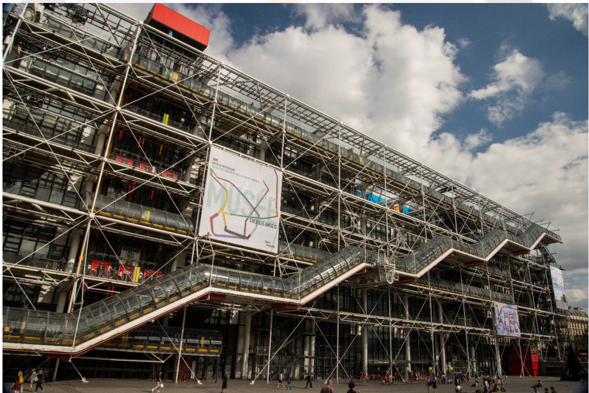
Figura 2.20. Centro Georges Pompidou terminado en 1977, París, Francia. Resultó ser un edificio icónico ideado para reurbanizar el barrio de Le Marais. Pablo Vázquez Piombo, 2016.
