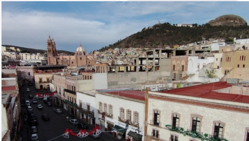
Figura 6.21. Ciudad de Zacatecas, Zacatecas, 2016. Calle Tacuba, construcciones con volúmetrías excesivas donde se demolieron interiores para albergar estacionamientos vehiculares, la fachada aún se conserva, el escalonamiento de los niveles superiores resulta en una obstrucción de las continuidades visuales. Pablo Vázquez Piombo, 2016.
