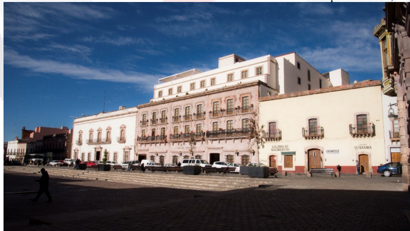
Figura 6.22. Ciudad de Zacatecas, Zacatecas, 2018. Hotel Emporio Calle Hidalgo frente a la plaza de armas. Su intervención resultó polémica, el contexto circundante a la plaza de armas presenta con una severa afectación volumétrica aun cuando se determinó escalonar los niveles superiores para ser metidos respecto a la fachada. Pablo Vázquez Piombo, 2018.
