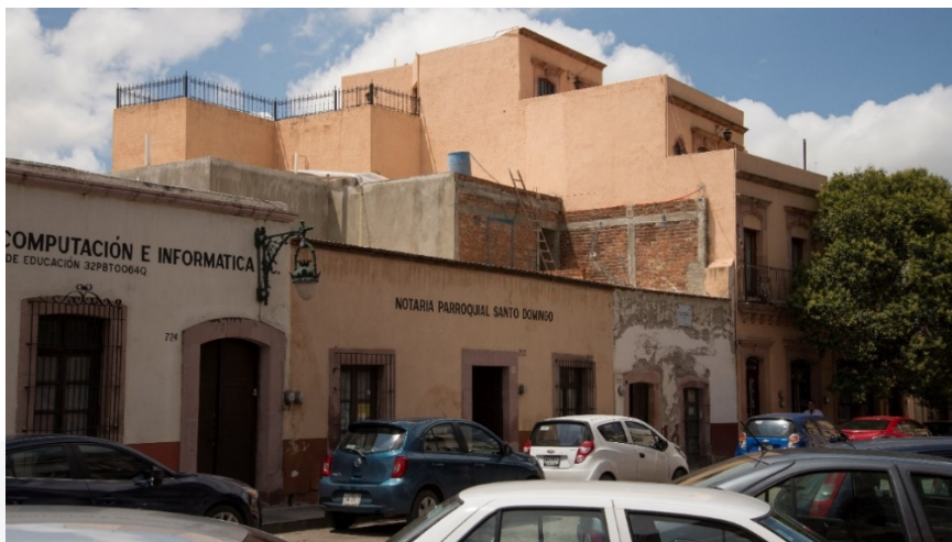
Figura 6.23. Ciudad de Zacatecas, Zacatecas, 2018. Inmueble privado, calle Genaro Codina. Su intervención es resultado de un estudio sobre la fachada principal, con el propósito de escalonar los niveles superiores autorizados para ser metidos respecto al primer paramento. Es evidente en esta imagen que no se previó el resultado en las fachadas laterales, ya que el impacto dentro del contexto es negativo y presenta una afectación considerable. Pablo Vázquez Piombo, 2018.
