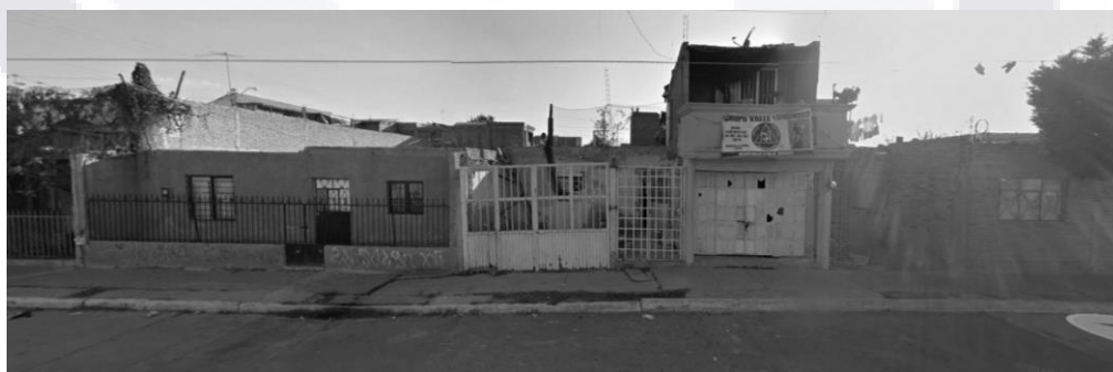
Figura 31. Vista Sur, zona crítica en Ciudad de Aguascalientes.
