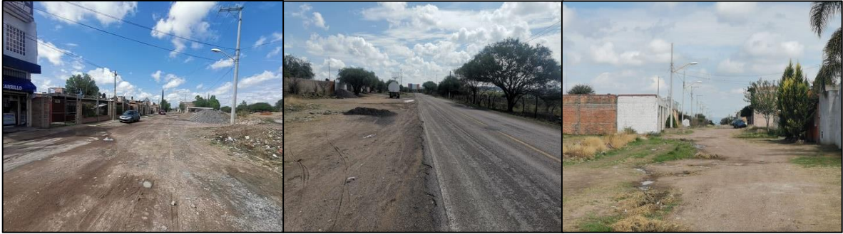
Imagen 7. Estado de vialidades en comunidad Refugio de Peñuelas
