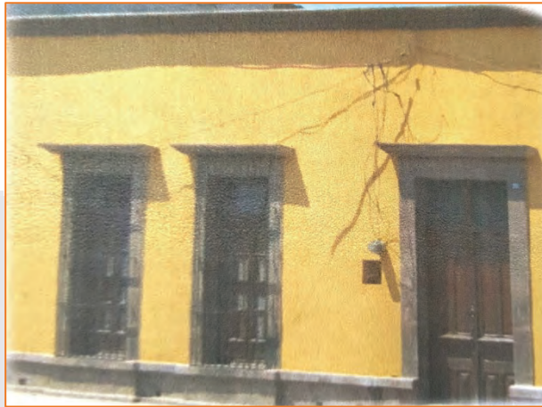
Imagen 5.6 Fachada típica barrial colindante al Centro Histórico de San Luis Potosí, en donde se puede observar un arreglo más sencillo sin ningún tipo de remate sobre los dinteles, pero conserva sus características formales elaborados en cantera en la vivienda del sector medio
