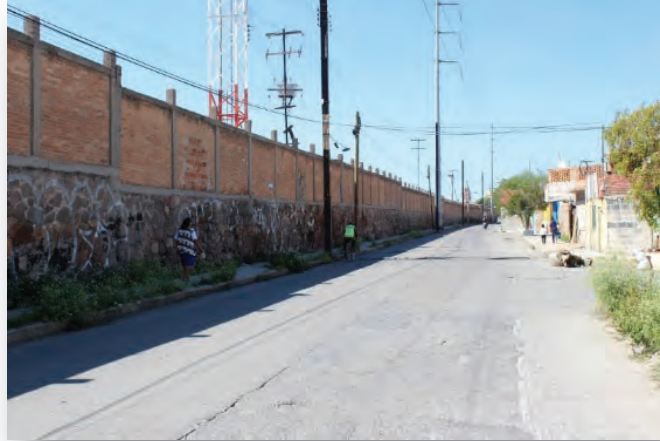
Imagen 4.14 Vista de la calle Azteca Sur delimitada por la barda del ferrocarril. Obsérvese como esta construcción forma una barrera urbana real.
