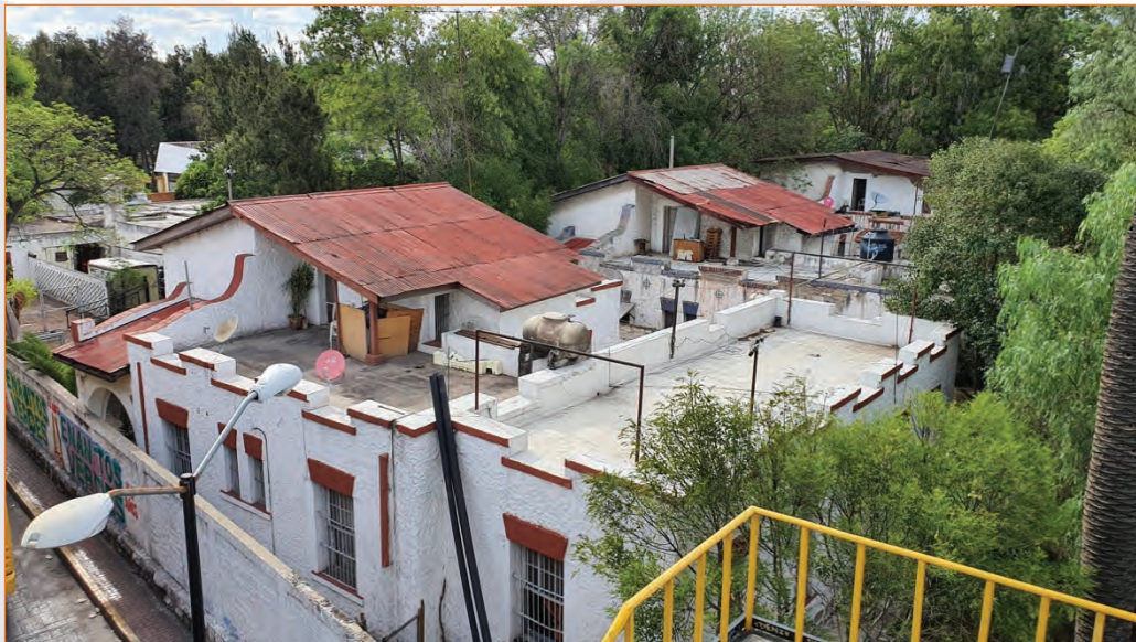
Imagen 7.4 vista de viviendas tipo chalet construidas para alojar a personal administrativo extranjero del ferrocarril durante la etapa de estudio. Nótese la tipología arquitectónica y los materiales empleados en las techumbres.
