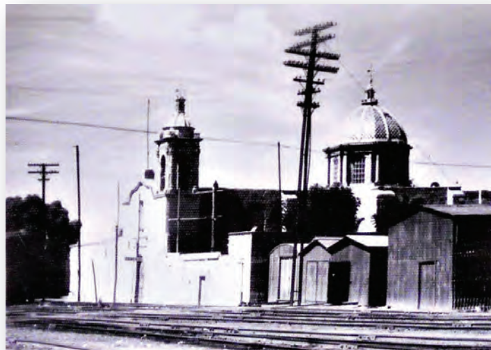
Imagen 2.5 Imagen de la portada original del templo del Montecillo a finales del siglo XIX o principios del XX en donde se puede apreciar las primeras instalaciones ferroviarias antes de la construcción de la barda perimetral
