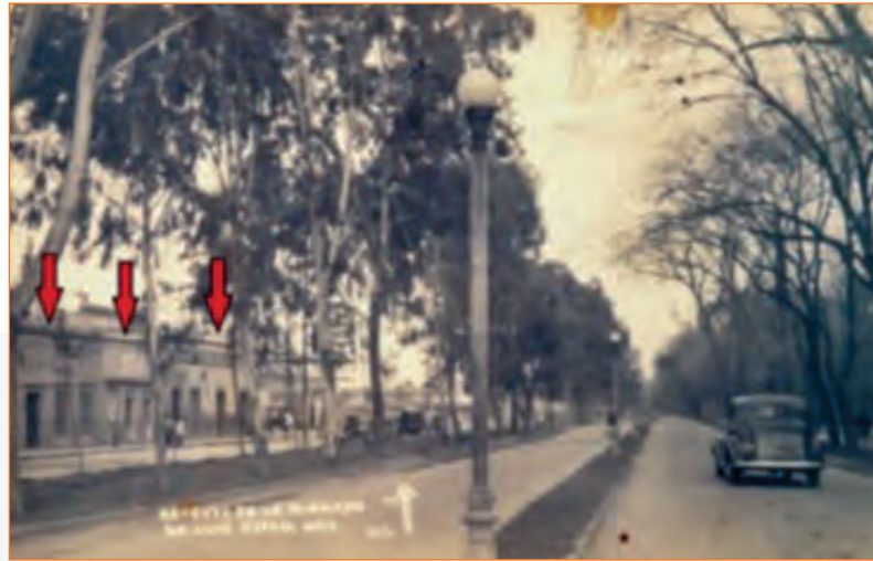
Imagen 6.32 Lado norte de la Alameda a mediados de 1920. Las flechas rojas señalan las alturas similares de las fachadas en toda la cuadra. Nótese el detalle del camellón central con alumbrado y el camellón lateral arbolado.
