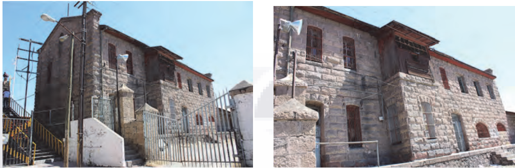
Imagen 6.63 Fotografías de las fachadas norte y poniente del edificio de bodegas del Ferrocarril Nacional Mexicano. Nótese la terminación con almohadillado de cantera labrada
