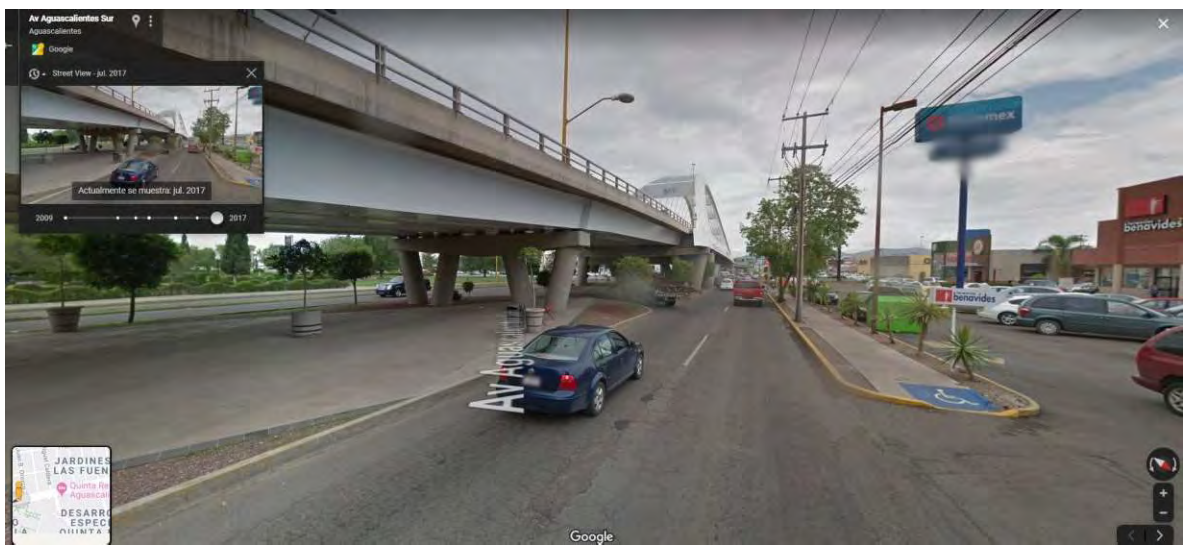
Figura 39. Vista de oriente poniente sobre Av. Aguascalientes julio 2017. Después de paso a desnivel
