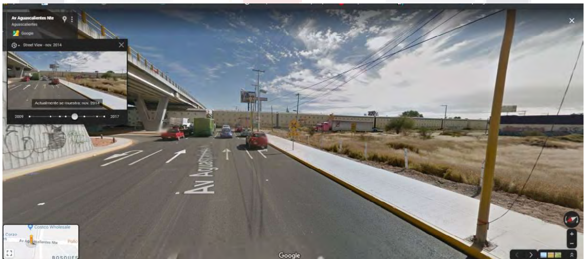
Figura 53. Vista de poniente oriente de Av. Aguascalientes noviembre 2013
