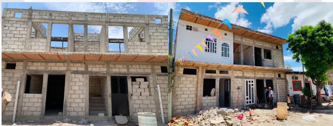
Figura 37. Construcción de vivienda en calle Venecia
