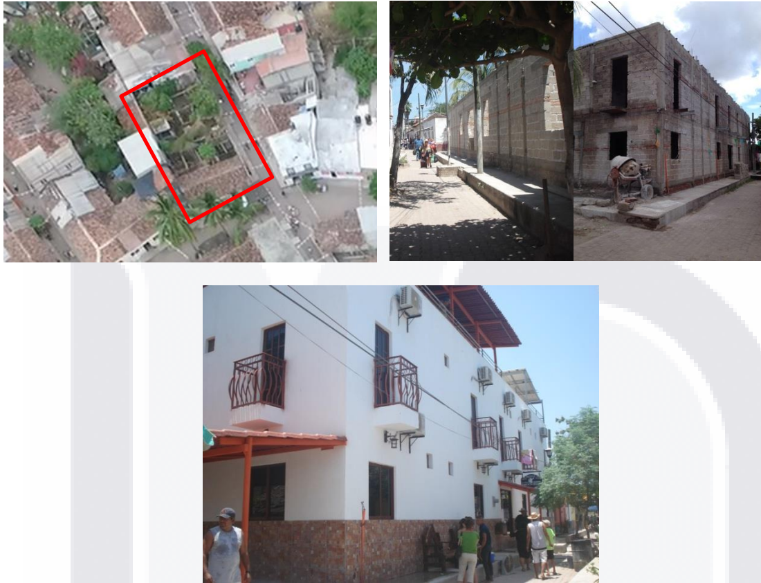
Figura 35. Demolición de una vivienda tradicional para la construcción de un hotel
