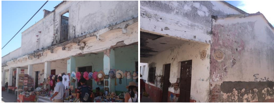
Figura 38. Portales del lado sur y el lado oeste de la plaza
