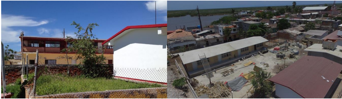
Figura 36. Demolición de la escuela primaria
