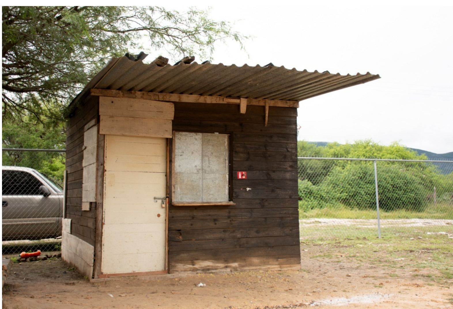
Fotografía 11. Construcción de madera para venta de alimentos y bebidas al interior del plantel.
