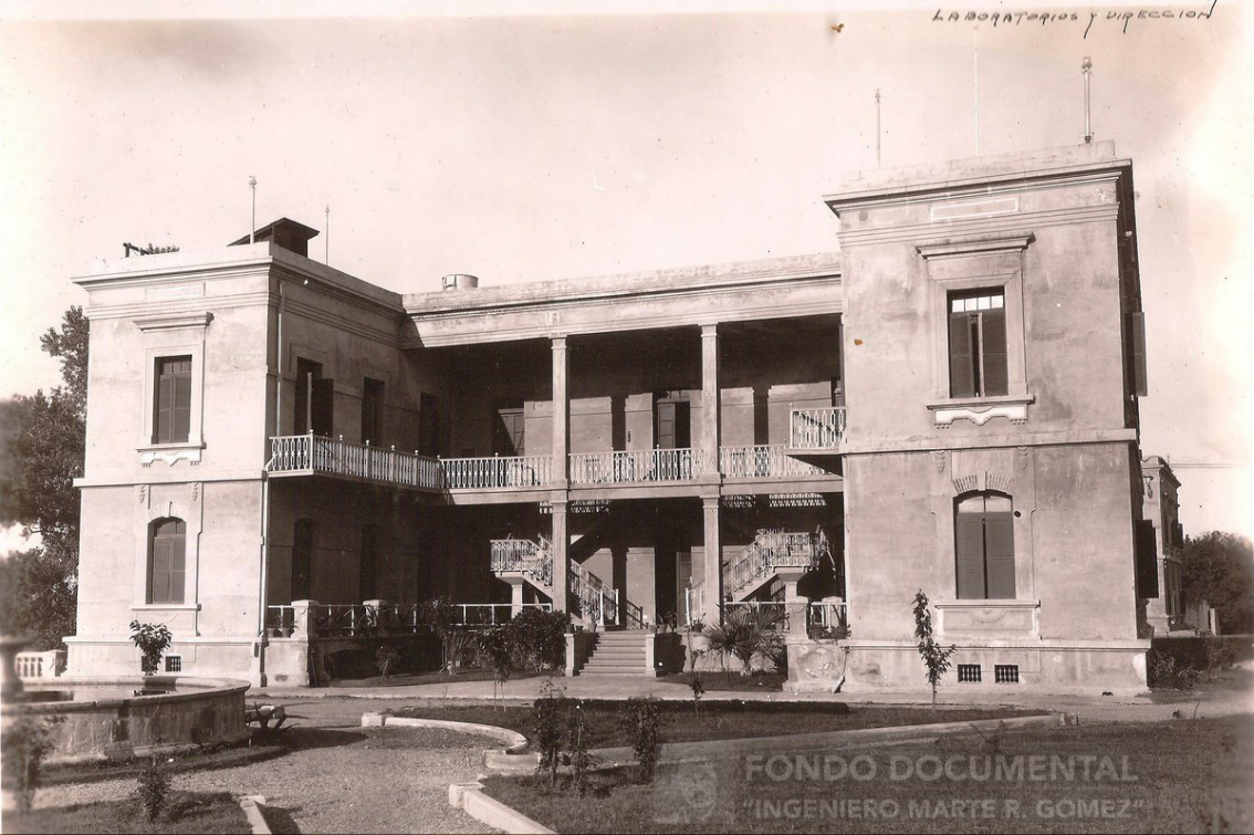
Ilustración 7. Edificio principal o central. Dirección y oficinas administrativas. Fuente: Fondo Ing. Marte R. Gómez, 1929.
