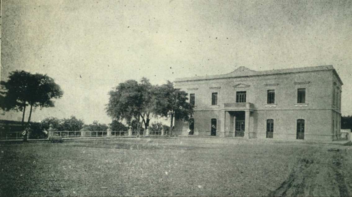
Ilustración 8. Edificio de exhibiciones y dormitorios.
