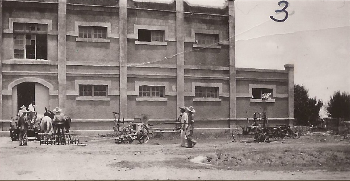
Ilustración 17. Dormitorio y almacén. Fuente: AGN, SEP, DEANR, caja 33454, informe de los trabajos ejecutados en la Regional Campesina y Normal Rural de Tamatán, por el Ing. comisionado Job P. Villegas. 17 de julio de 1935.
