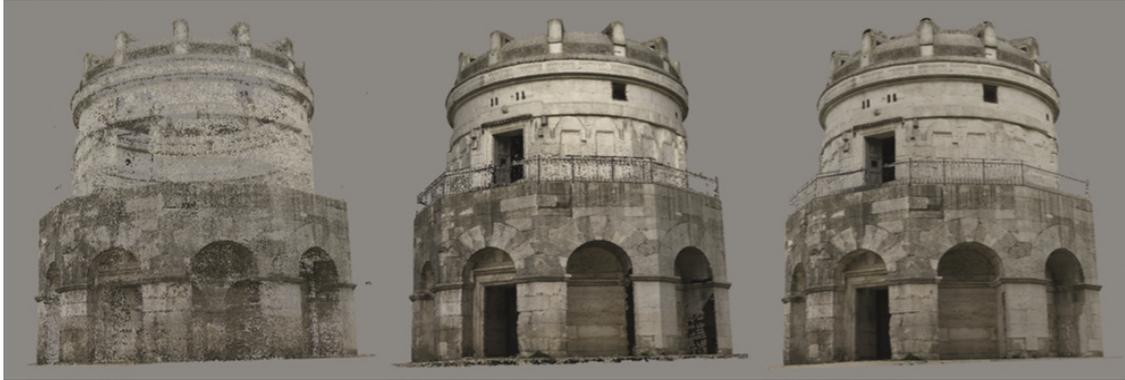
Ilustración 5 Nube de puntos, Modelo sin correcciones, Modelo con correcciones. (Luca Cipriani et al., 2015)
