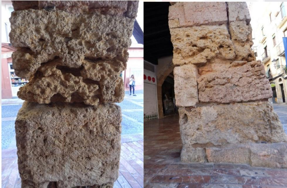
Ilustración 38 Columna erosionada Tarragona (M. Soto)
