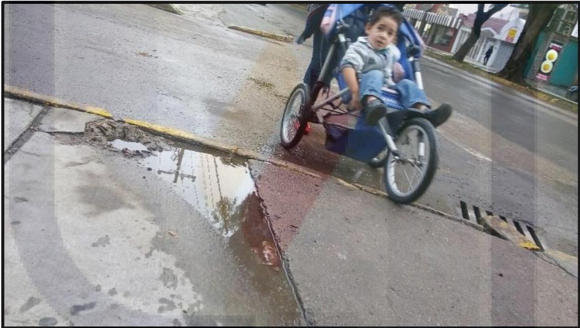
Ilustración 136. Banqueta sin rampa, tramo 4. Fuente: Elaboración propia.
