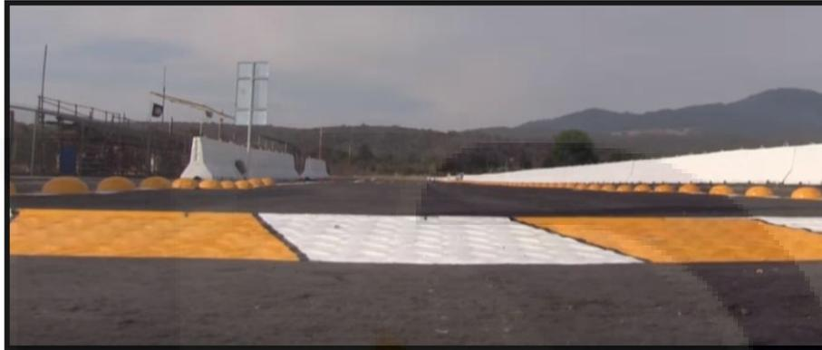
Ilustración 206. Tope inteligente, posición abajo. Fuente: Tráfico ZMG
