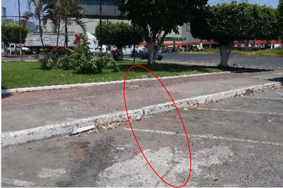
**Figura 21.** Fractura en estacionamiento de tránsito y vialidad del estado de Nayarit vista hacia el Oeste.
