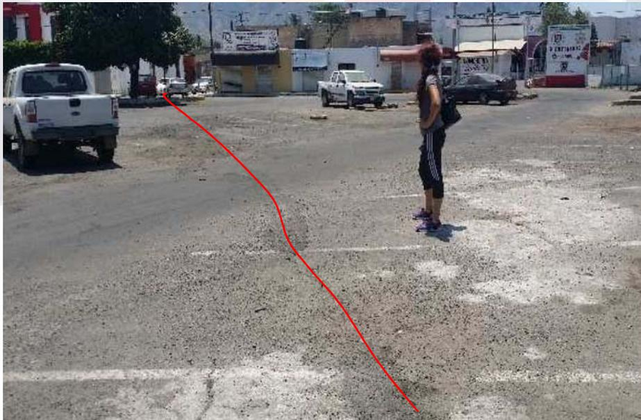
**Figura 22.** Fractura en estacionamiento de tránsito y vialidad del estado de Nayarit vista hacia el Este.
