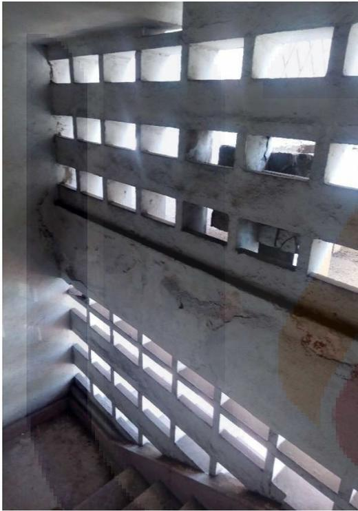
Imagen 181, Celosías que permiten la iluminación y ventilación al interior del edificio. (Yáñez, 2018)
