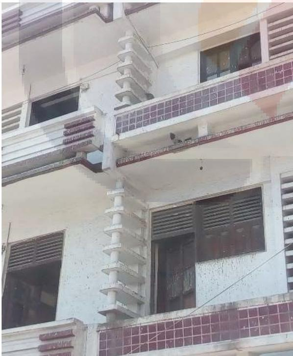
Imagen 184 Parteluces de concreto prefabricados, (Yáñez, 2018)
