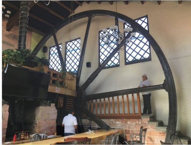
Ilustración 59: Exterior de la casa de máquinas Cornish sur en la Hacienda Nueva (Proaño) donde todavía se observa el balancín posterior. El volante de esta máquina se ha cubierto con parte del club para los empleados de la compañía. Fuente: José Humberto Flores Castro.
