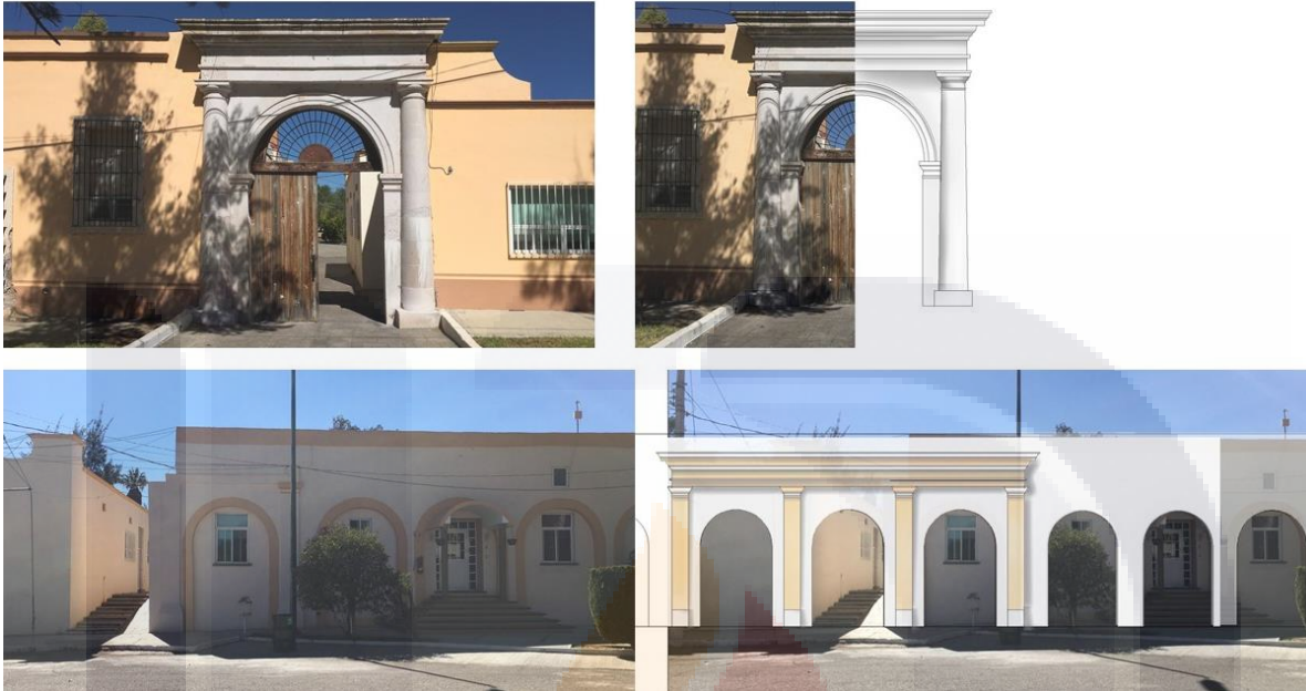
Ilustración 82: Los únicos restos del primer conjunto arquitectónico de la Hacienda Nueva conservados en la actualidad han sido empleados para reconfigurar el esquema original de los 1830s. Fuente: José Humberto Flores Castro.
