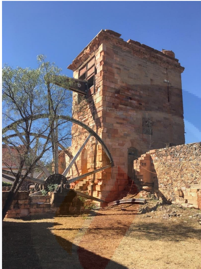
Ilustración 54: La Casa de Máquinas Cornish Norte al interior de la Hacienda Nueva. Nótese, por las partes caídas, que los volantes estaban hechos en partes, para su fácil transporte. Fuente: José Humberto Flores Castro.
