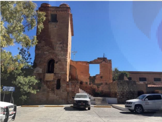
Ilustración 60: A la izquierda se muestra la parte posterior de la casa de máquinas Cornish norte, con el espacio donde estarían las calderas y el segundo balancín. Nótese los dos agujeros que permitían el paso de las calderas a las chimeneas. Fuente: José Humberto Flores Castro. A la derecha, foto tomada en 1922, donde aparece el espacio de las calderas transformado en vivienda que aparece en (BLAMEY, 1982, PÁG. 4).
