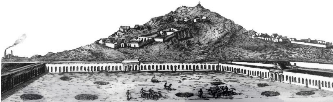
Ilustración 25: Representación de la instalación original de la Hacienda Nueva. Al centro, las labores de beneficio de la plata por el método de patio. Fuente: José Humberto Flores Castro, basado en la lámina del "Museo Mexicano" de 1843.
