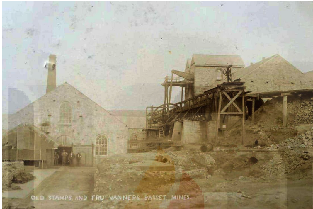
Ilustración 52: El molino de mazos accionado con vapor de las minas Basset. Se colocarían dos máquinas que, además de accionar los mazos, bombearían agua en la parte posterior de la casa de máquinas para agregar a la lama. Fuente: fotografía de la colección digital de Jory Bennet.
