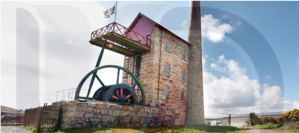
Ilustración 46: Casa de máquinas Cornish Michell en la mina East Pool en Redruth, Cornualles, cerca de Truro, donde se fabricaron las bombas que se instalarían en la Hacienda Nueva. Fuente: foto de Bill Amey, obtenida de https://www.nationaltrust.org.uk/east-pool-mine .
