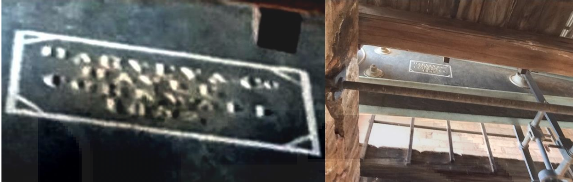
Ilustración 53: La placa de "Harvey & Hayle, Cornwall, 1852" colocada sobre el balancín principal de la casa de máquinas Cornish norte, en 2016. Fuente: José Humberto Flores Castro.
