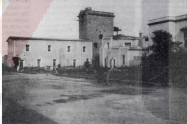
Ilustración 60: A la izquierda se muestra la parte posterior de la casa de máquinas Cornish norte, con el espacio donde estarían las calderas y el segundo balancín. Nótese los dos agujeros que permitían el paso de las calderas a las chimeneas. Fuente: José Humberto Flores Castro. A la derecha, foto tomada en 1922, donde aparece el espacio de las calderas transformado en vivienda que aparece en (BLAMEY, 1982, PÁG. 4).
