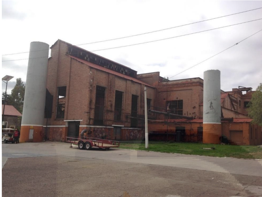
Ilustración 89: La planta de energía eléctrica vista desde el exterior en 2017. Los torreones se derruyeron en la década de los ochentas, para prevenir riesgos de derrumbe. Fuente: José Humberto Flores Castro.
