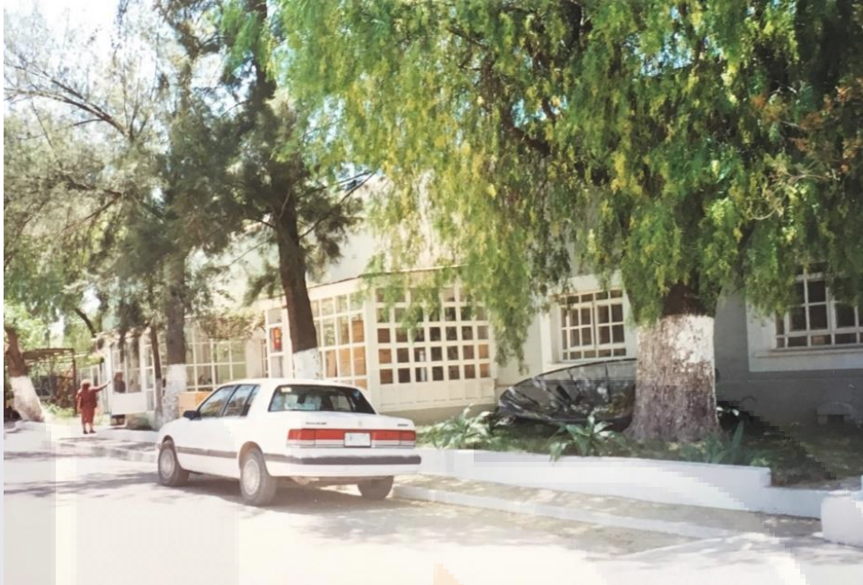
Ilustración 81: Aquí se muestran algunas de las casas habitación construidas al interior de la Hacienda Nueva, hoy conocida como "Proaño". 1993. Un elemento tipológico adicionado por los norteamericanos fue el porche, que, en la actualidad, ha sido removido. Fuente: José Humberto Flores Castro.
