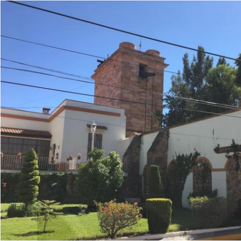
Ilustración 59: Exterior de la casa de máquinas Cornish sur en la Hacienda Nueva (Proaño) donde todavía se observa el balancín posterior. El volante de esta máquina se ha cubierto con parte del club para los empleados de la compañía. Fuente: José Humberto Flores Castro.
