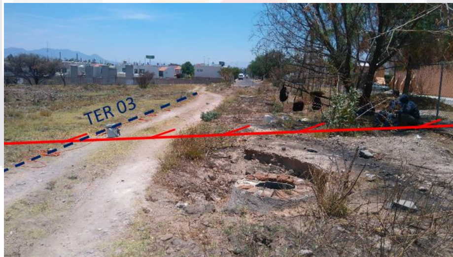
Figura 21. Fotografía del pozo de visita ubicado en la zona del sitio donde se levantaron los perfiles de las TER 03 Y 04.
